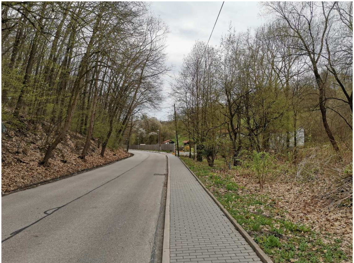
Obr. 12 – Silnice II/105, pohled směrem Neveklov
