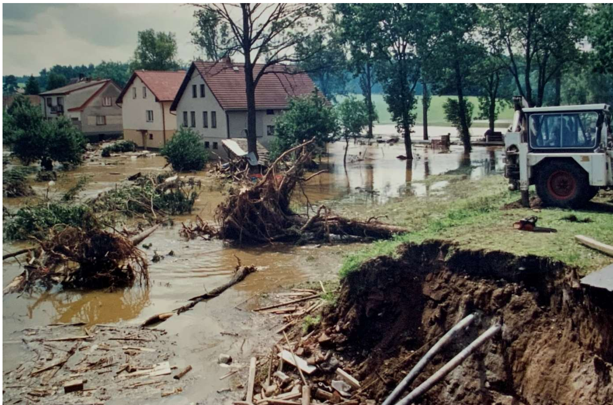
Obr. 3 – Pohled na levobřežní zástavbu RD po povodních 2002 [Archiv obce Plav].
