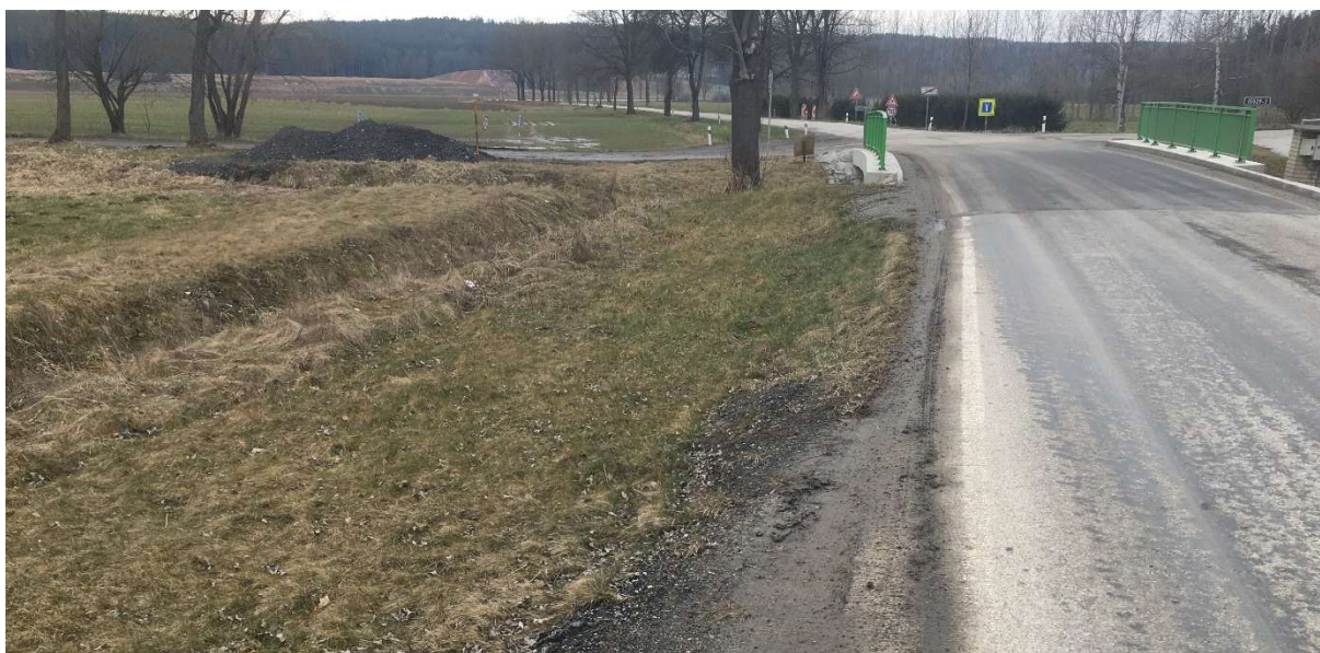
Obr. 9 – Pohled na mostek začátku trasy PPO II.
