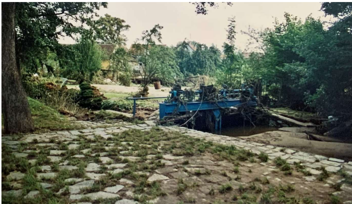
Obr. 4 – Pohled na náhon Mlýnské stoky po povodních 2002 [Archiv obce Plav].
