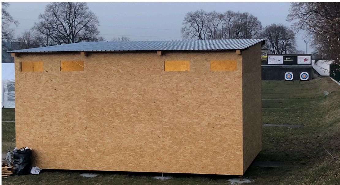
■ Obrázek 4.5 Budova pro střílení mimo letní sezonu. Na přední straně jsou uzavíratelné střílny, v pozadí 70 m vzdálené terče.
