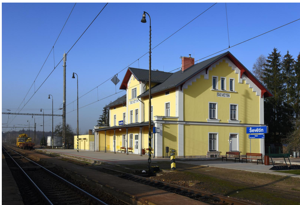
Obrázek 7. Železniční stanice Ševětín ve stavu před rekonstrukcí (foto autor 2021)
