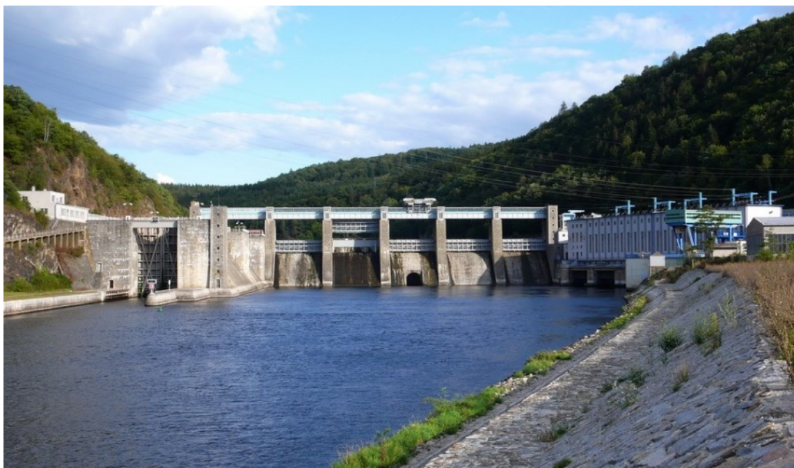
Obrázek 12 – Vodní dílo Štěchovice, v levé části jsou viditelná vrata plavební komory. [53]
