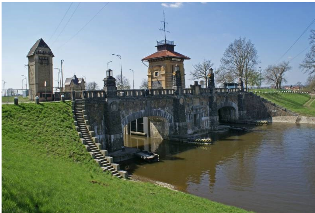
Obrázek 11 – Plavební komory s mostem, součást plavebního kanálu Vraňany – Hořín. [51]
