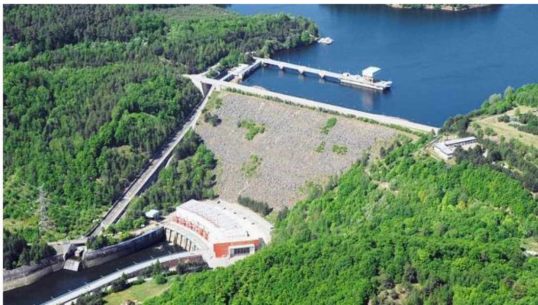
Obrázek 6 – Nejvyšší přehrada v ČR Dalešice s výškou hráze 100 m. [24]
