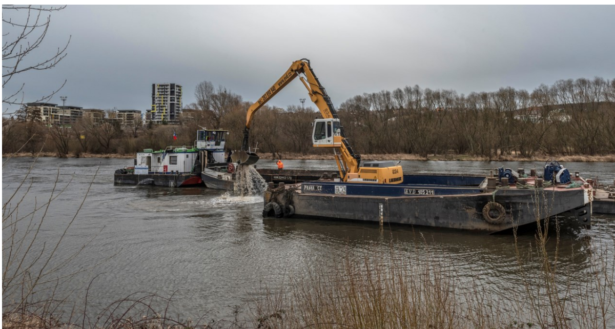
Obrázek 7 – Hloubení říčního dna v rámci projektu „Zvýšení ponorů na Vltavské vodní cestě“. [32]
