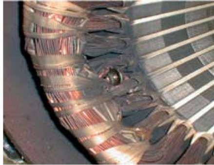
Obrázek 9 – Rozbitá část ložiska ve vinutí [1]
