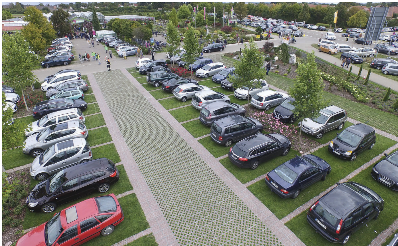
42. jedno z parkovišť postavených pomocí inovativních zatravnovacích dlaždic AS-TTE (zdroj: tzb-info.cz)
