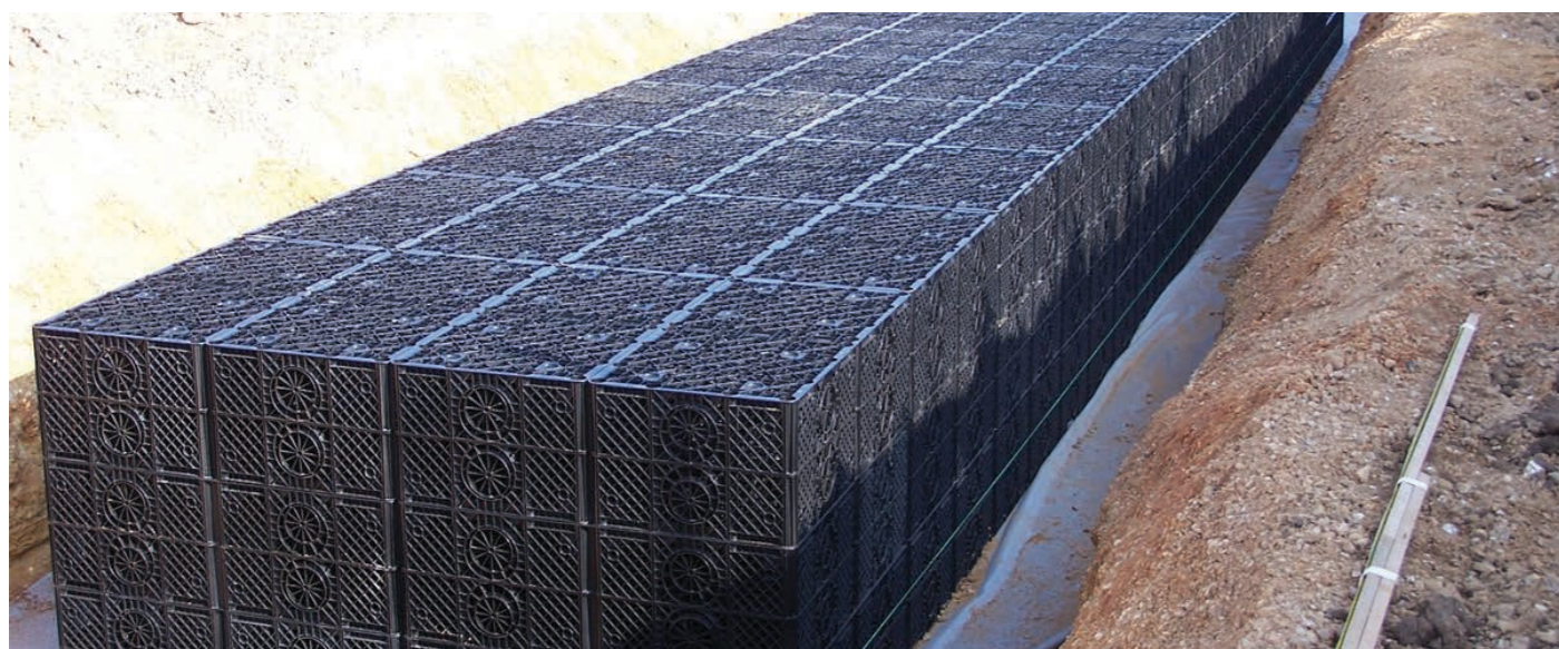
37. proces instalace podzemní vodní nádrže z jednotlivých plastových boxů (zdroj: tzb-info)
