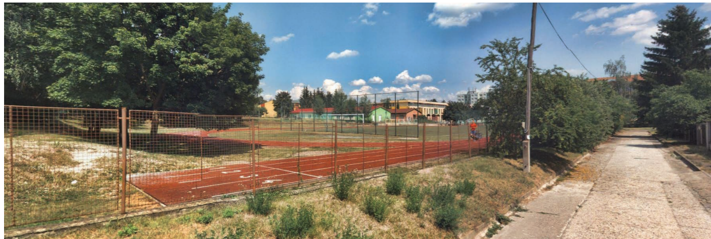
b. pohled na hřiště s běžeckým okruhem z jižní strany
