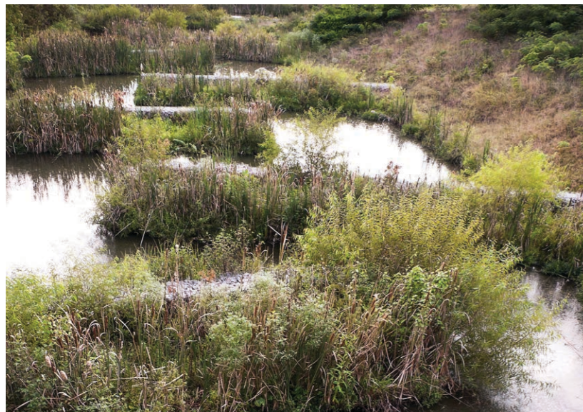
25. výrazně zpomalený tok vlivem pažení toku jednotlivými gabiony, Northshore District, Chattanooga, Tennessee (zdroj: https://www.flickr.com/photos/kenmccown )
