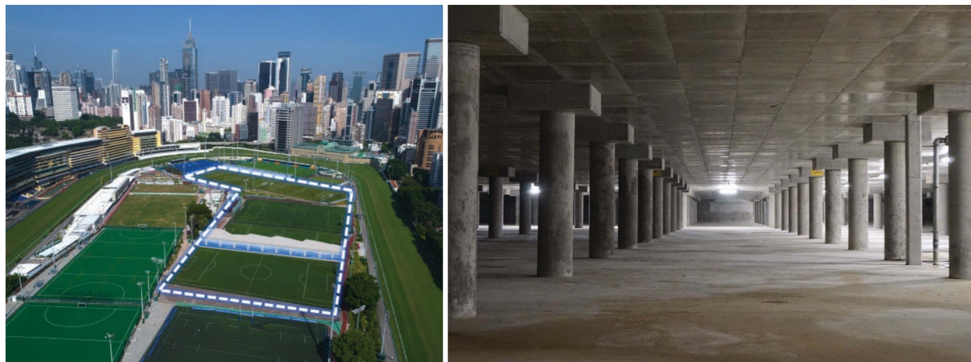
35. objemná podzemní zásobárna dešťové vody pod sportovními hřišti v Happy Valley, Hongkong (zdroj: iwa-network.org)
