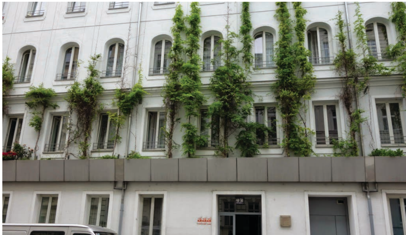
58. Wistaria na lankových konstrukcích, ulice Embelgasse, Vídeň (zdroj: zahradanastenu.cz)
