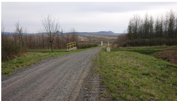
Silnice vedoucí k těžební jámě ukončená závorou; dále smí jen vozidla se zvláštním povolením.
