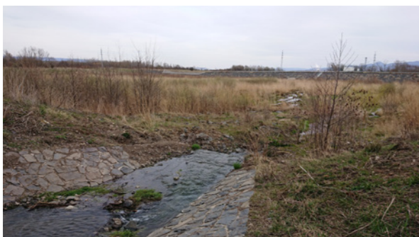
Místo, kde je Radčický potok sveden do podzemního potrubí a odveden z oblasti pryč.
