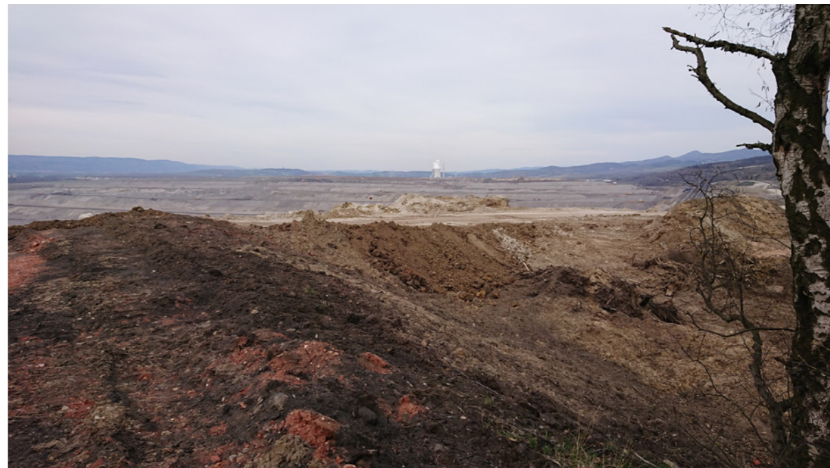
Pohled na celou těžební jámu ze silnice vedoucí v její těsné blízkosti. Jáma je tak hlboká, že nelze vidět na její dno.
