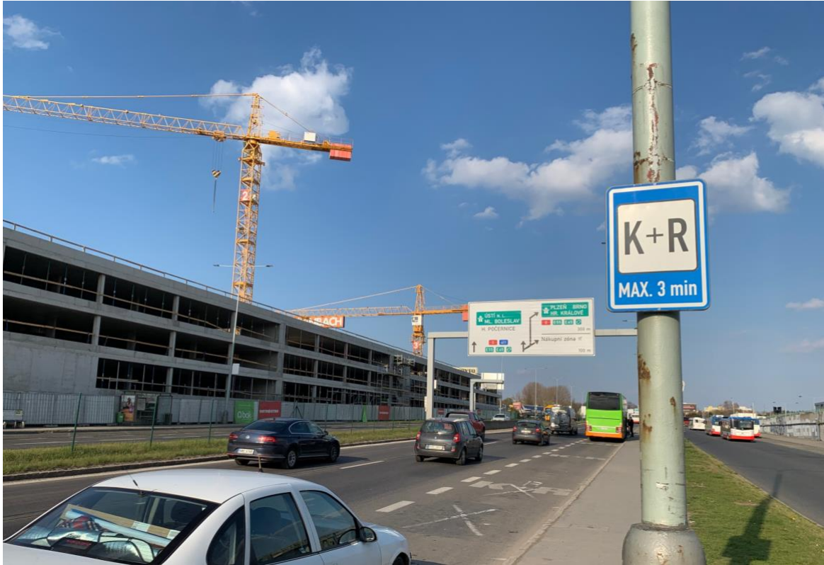
Figure 1: K+R Černý Most (Chlumecká street, direction to Horní Počernice) (28.04.2021)
