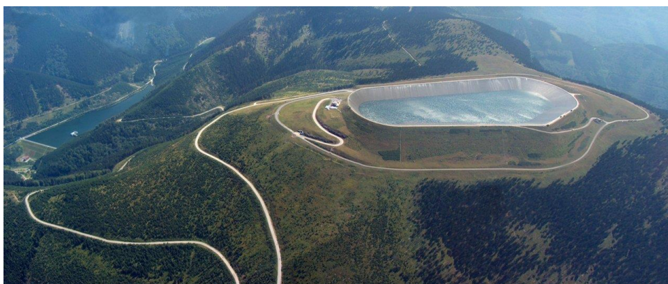
Obr. 2.1: Přečerpávací elektrárna Dlouhé stráně 4
