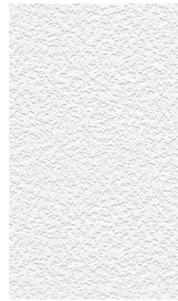
Bílá stěrka ve struktuře omítky
