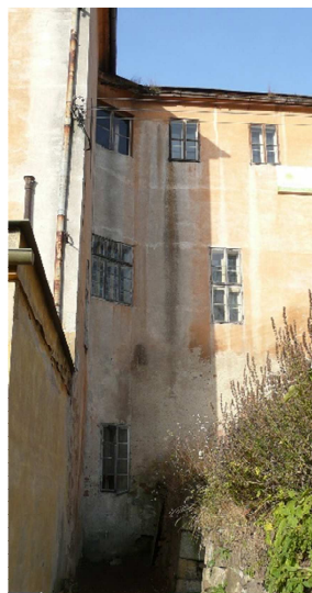
Obr. 18: Dvorní fasáda - objekt tzv. Starého opatství, areál kláštera, Plasy
