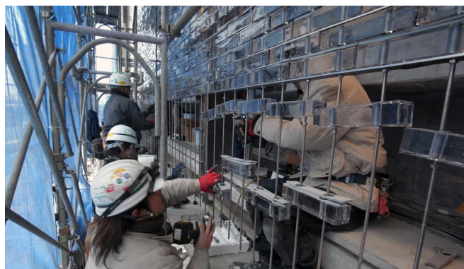
(b) navlékání skleněných cihel na závitové tyče
