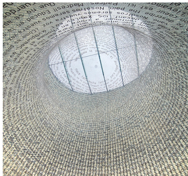
(b) ETFE membrána potíštěná vzkazy
