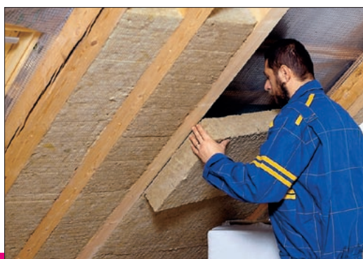
Ukázka aplikace výrobku Isover UNI
