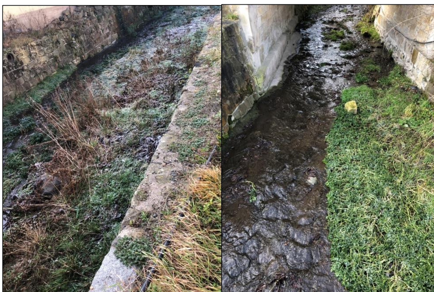
Obrázek 21: Úseky koryta potoku Poustka v obci Dobkovice, zdroj: vlastní
