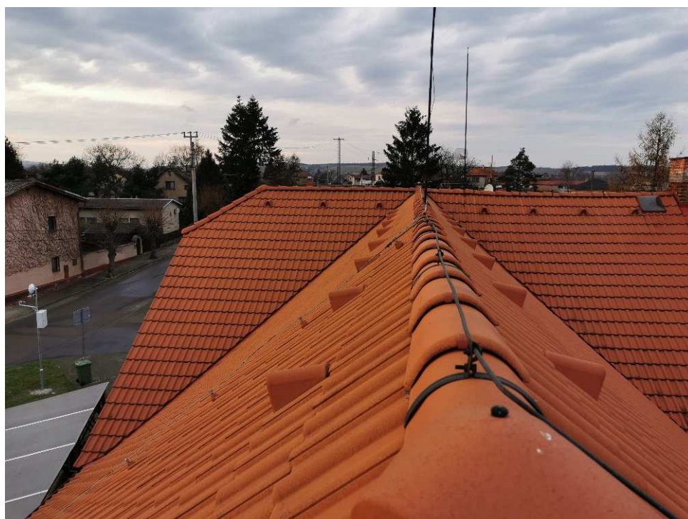
Obrázek 28, Pohled od hřebene na Část A
