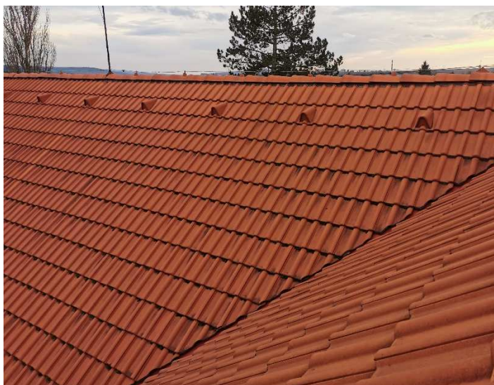
Obrázek 33, Stávající střešní krytina Bramac Classic Protector Plus
