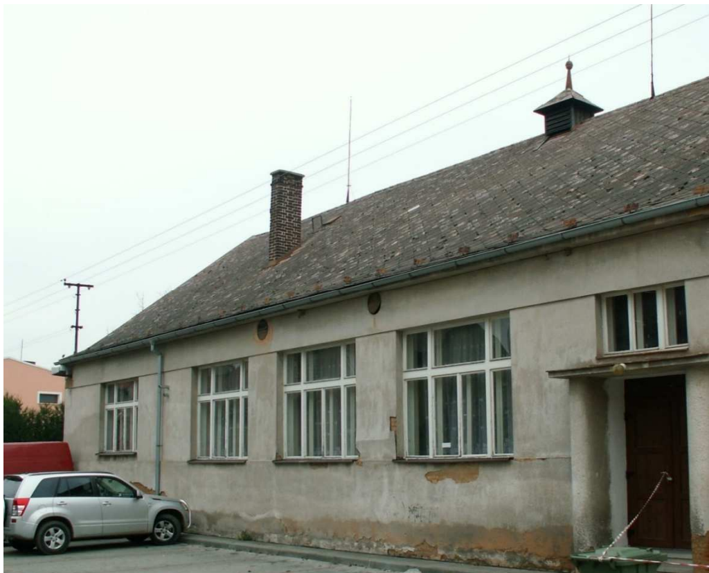
Obrázek 37, Severní pohled na Část B
