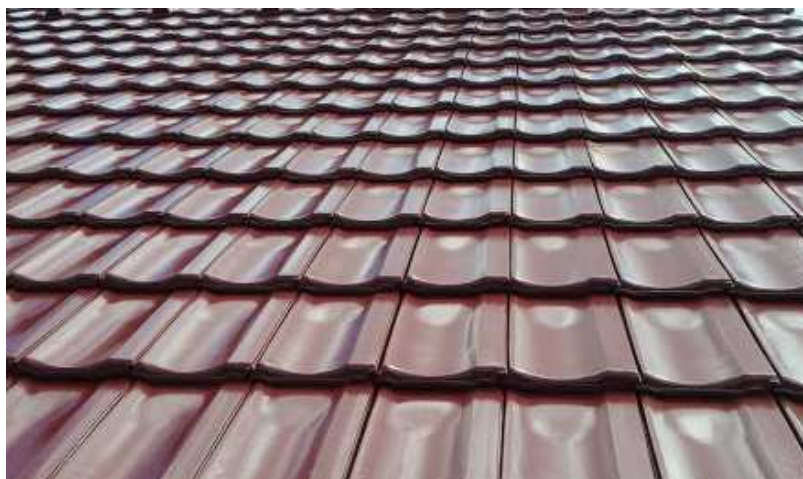
Obrázek 35, Střešní krytina Tondach Stodo glazura (24)
