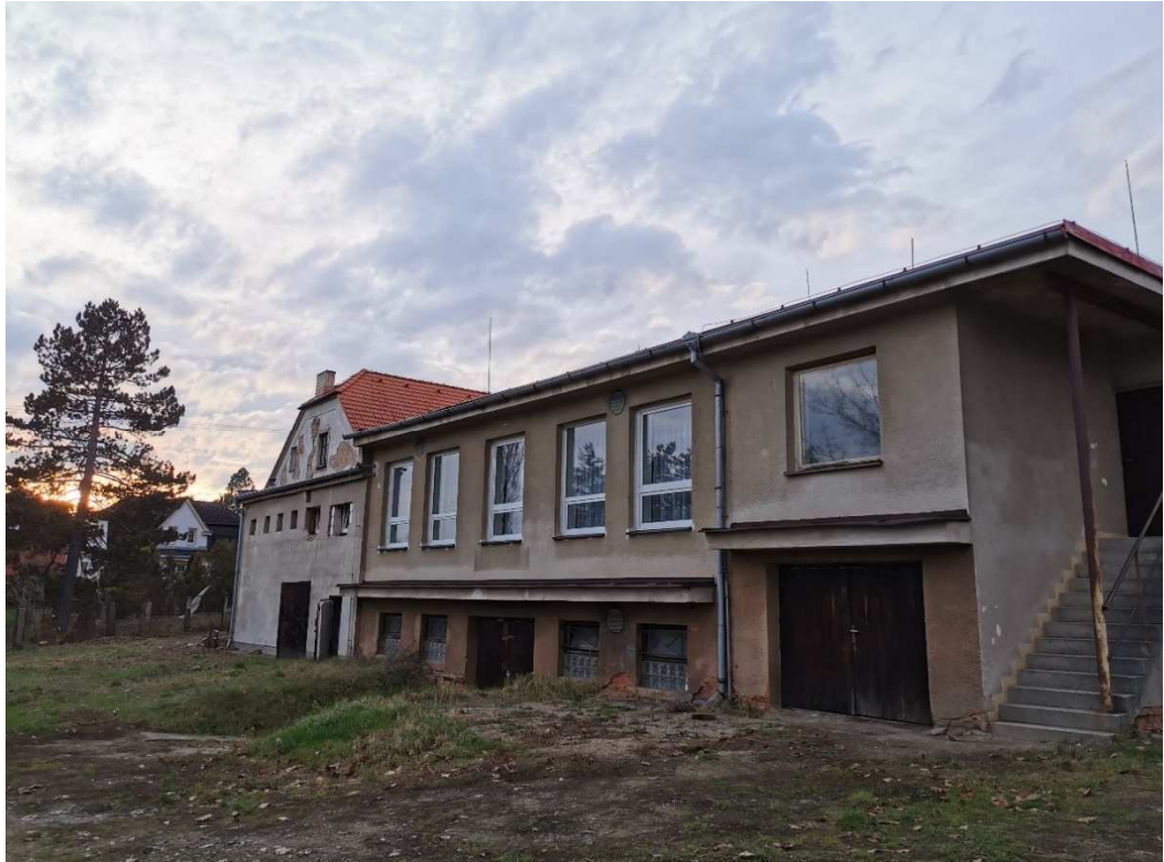
Obrázek 44, Východní pohled na Část C
