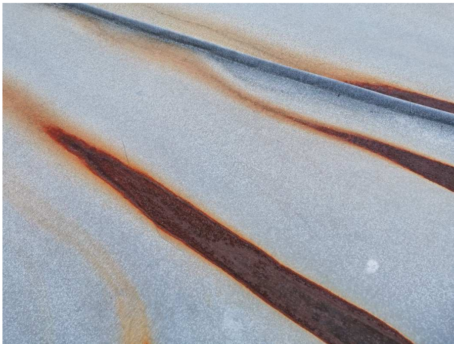
Obrázek 48, Rezavějící neošetřený trapézový plech
