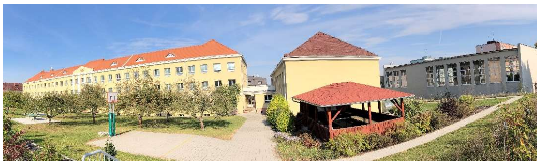
Obr. 3 – Pohled na budovu z jižní strany (ze zahrady)
