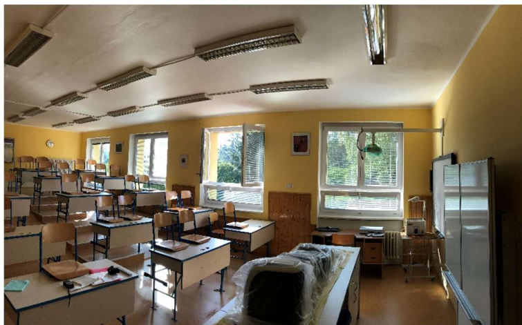
Obr. 22 – Pohled na stěnu s okny učebny fyziky (odstupňovaný parapet vzhledem k ustupující podlaze)
