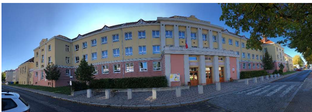
Obr. 2 – Současná podoba hodnoceného objektu (pohled ze severní strany)
