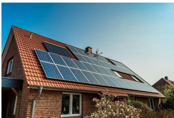
Obr. 3 - Polykrystalické fotovoltaické panely umístěné na střeše (12)
