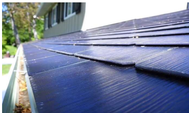
Obr. 5 - Fotovoltaické články integrované do střešního pláště od firmy Tesla (18)
