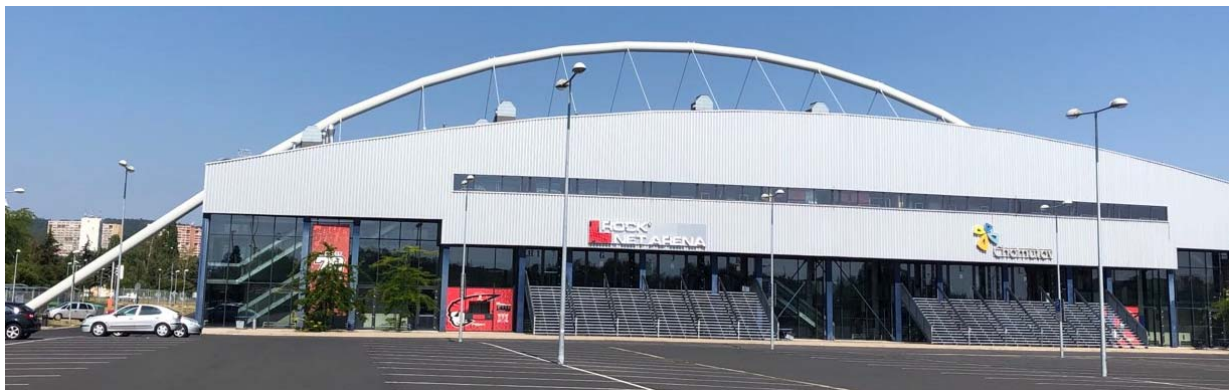
Obr. 15 Zimní stadion Chomutov zavěšená střešní konstrukce na předpjatém táhle
