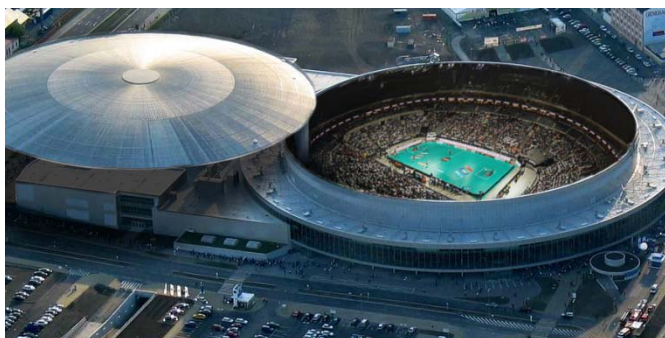
Obr. 12 O2 Arena exteriér [34]
