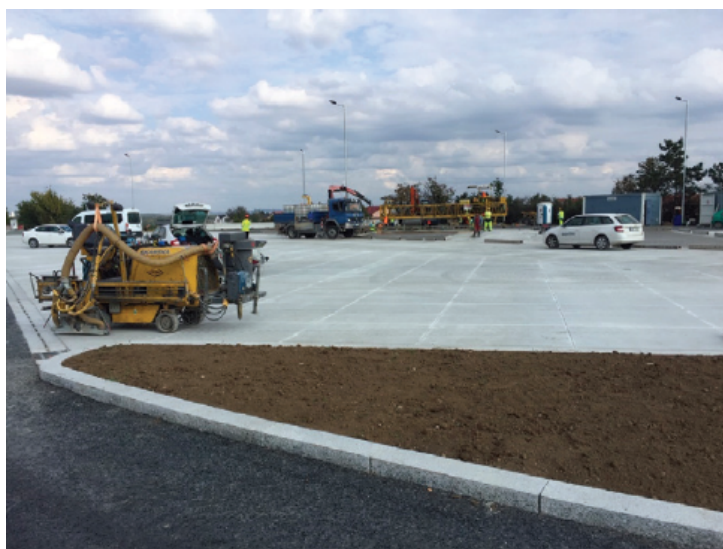
Obrázek 2.3: Úsek zhotovený metodou Whitetopping [43]
