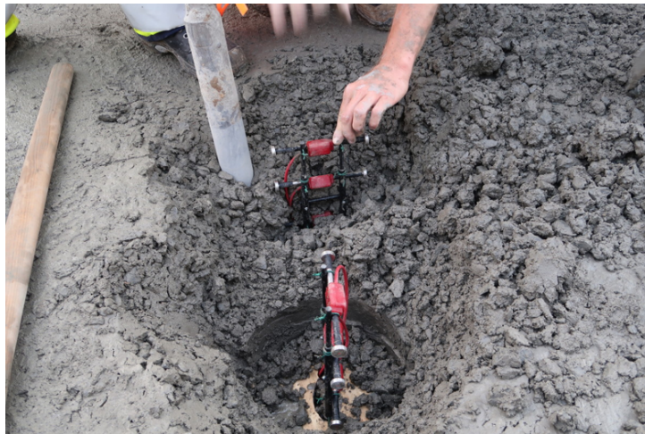
Obrázek 4.4: Pohled na dva měřící body během betonáže zkušebního úseku
