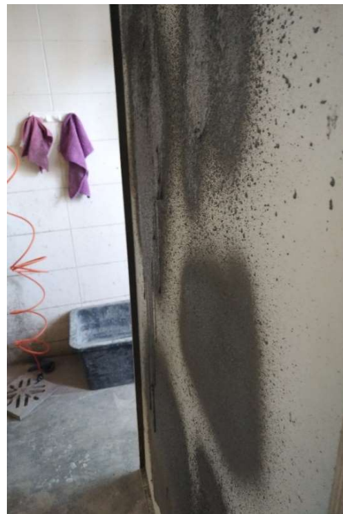
Obrázek 9: Profil zkušební bednění
