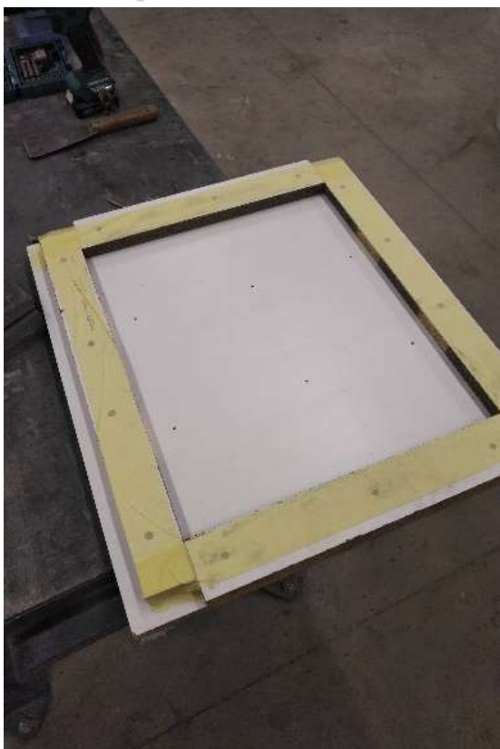
Obrázek 12: Zalepené bednění z LTD pro stříkaný beton
