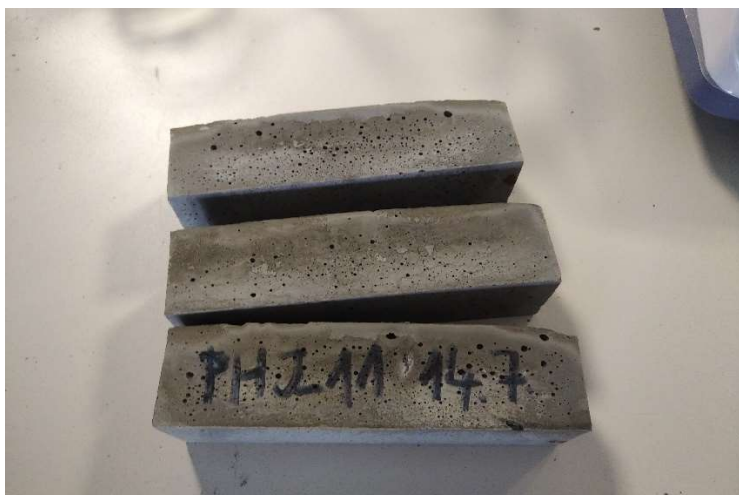
Obrázek 6: Póry v trámečcích pro zkoušku ohybem způsobené změnou konzistence pro stříkaný beton, vzorky PHJ_11
