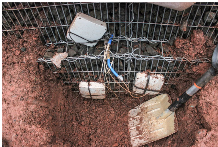
Obr. 11.2: Krabičky umístěné na čele gabionové konstrukce, foto Dušková, Š.
