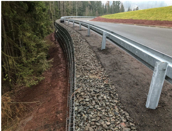
Obr. 9.1: Gabionové konstrukce km 1,320, foto Dušková, Š.
