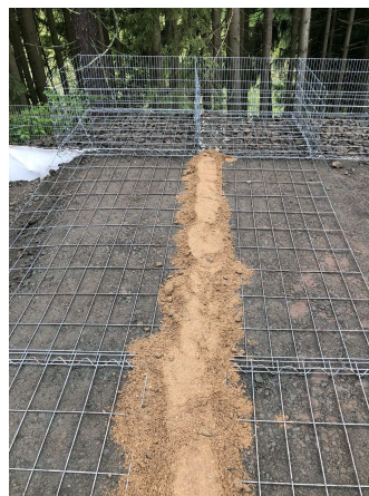
(b) Zakrytí FBG snímače pískem
