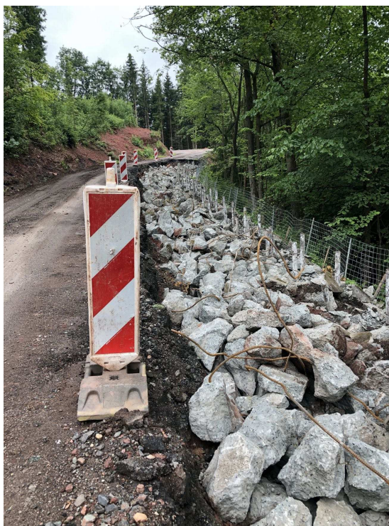
Obr. 5.5: Komunikace po sejmutí krytu vozovky, foto Dušková, Š.
