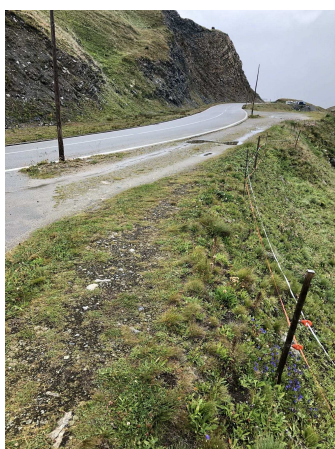
(a) Stav svahu komunikace
