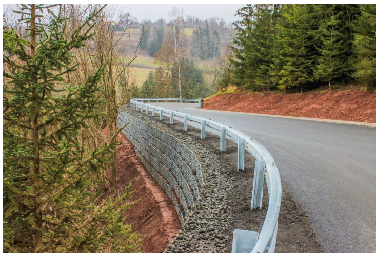
Obr. 9.2: Gabionové konstrukce km 1,500, foto Dušková, Š.
