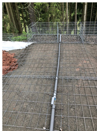
(b) Použití izolační trubice
