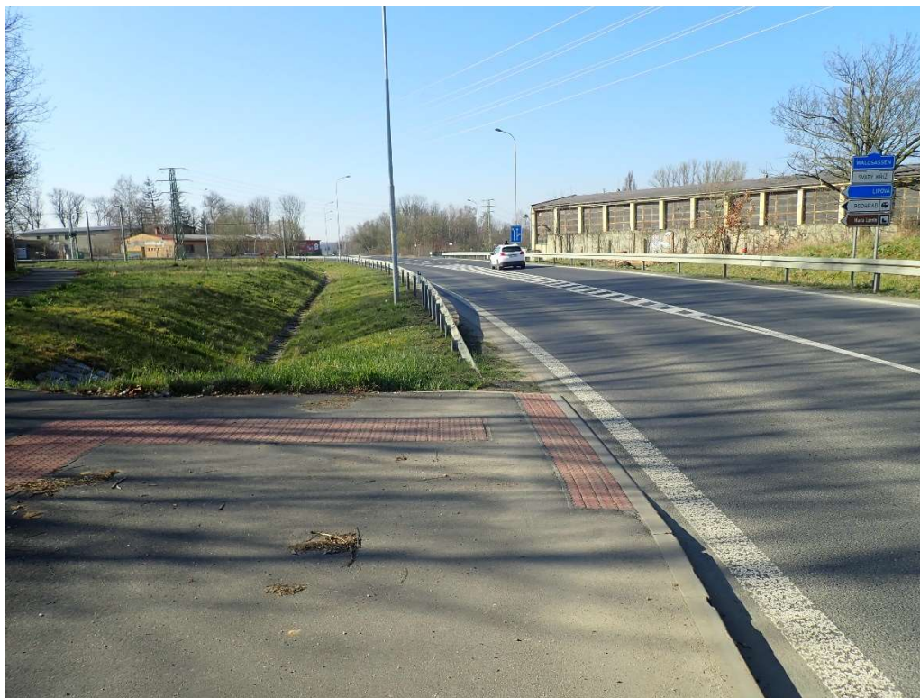
Obrázek 5 – pohled na silnici II/214 směrem do křižovatky ze směru od Karlových Varů
