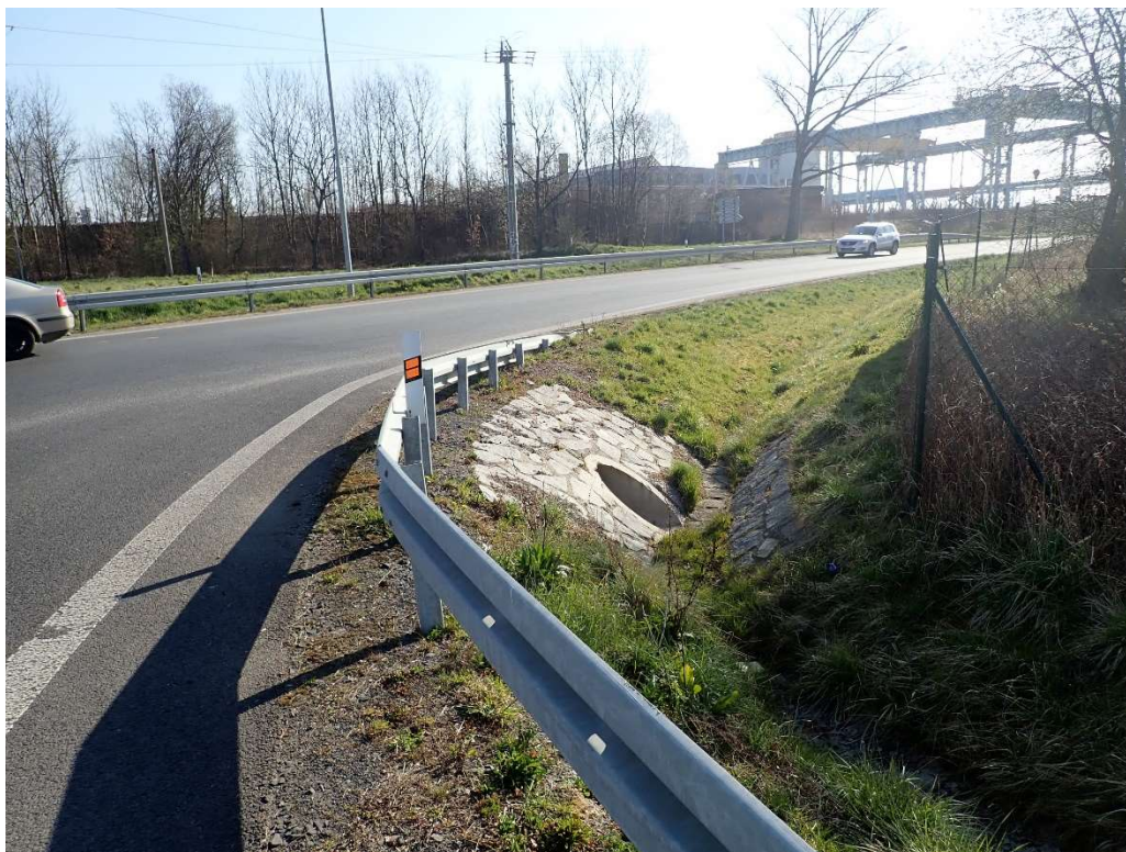
Obrázek 9 – jižní pohled na propustek pod silnicí III/2148
