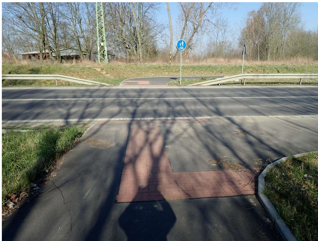
Obrázek 11 – pohled na místo pro přecházení na silnici II/214 s křižující se cyklostezkou
