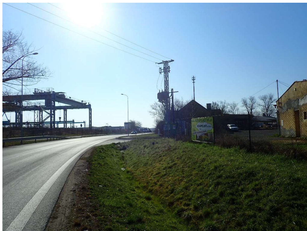
Obrázek 6 – pohled na silnici III/2148 směrem od křižovatky směr Podhrad
