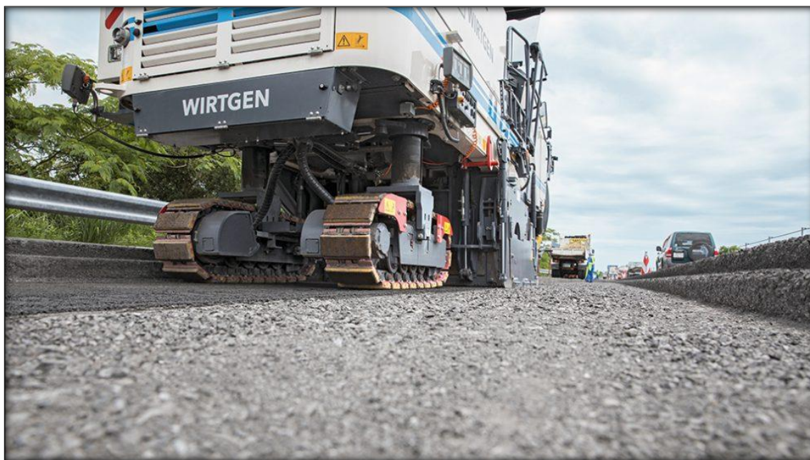
Obrázek 11: Selektivní frézování [45]
