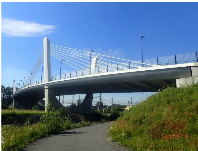
Obr. 6 Celkový pohled od opěry OP1 (foto: Tomáš Dejmek)
