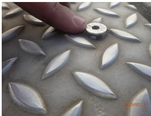
Obr. 13 Uvolněné šrouby u krycího plechu mostních závěrů (foto: Tomáš Dejmek)
