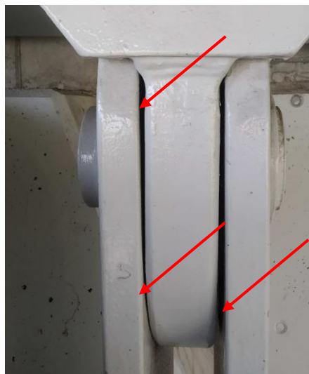
Obr. 63 Táhlo OP1-P – horní čep, patrné imperfekce (foto: Pavel Ryjáček)
