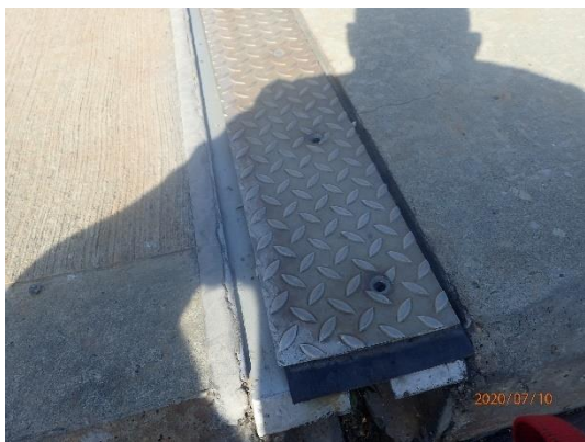
Obr. 12 Chybějící šrouby u krycího plechu mostních závěrů (foto: Tomáš Dejmek)
