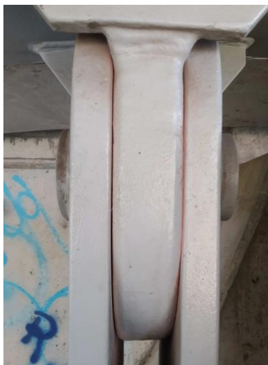
Obr. 62 Táhlo OP1-L – horní čep (foto: Pavel Ryjáček)
