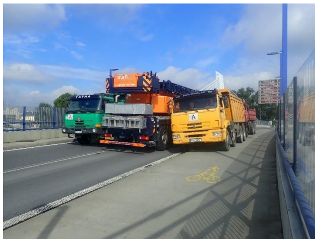
Obr. 48 Statická zatěžovací zkouška – zatěžovací stav ZS4 (foto: Tomáš Dejmek)
