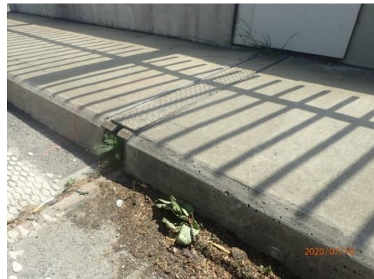
Obr. 11 Znečištění mostních závěrů (foto: Tomáš Dejmek)
