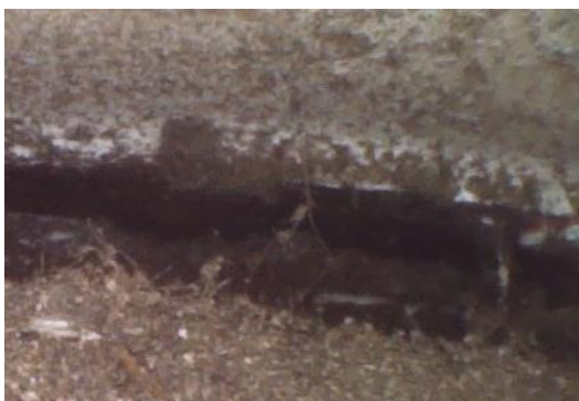
Obr. 15 Pohled na spáru mezi kluznými plochami na OP4-P (foto: Tomáš Dejmek)
