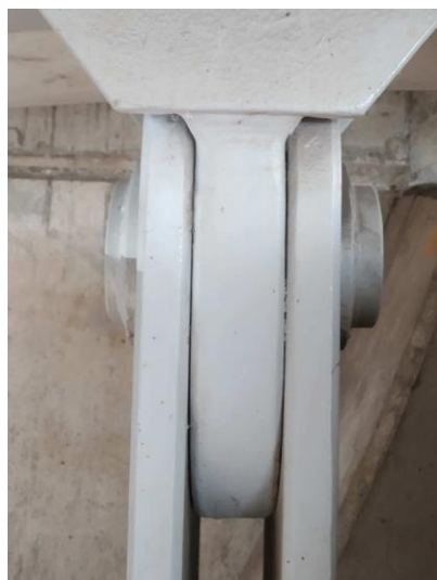
Obr. 65 Táhlo OP4-P – horní čep (foto: Pavel Ryjáček)
