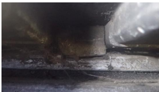
Obr. 14 Ložisko OP4-P, patrné natlačení ložiska na vodící lištu (foto: Tomáš Dejmek)
