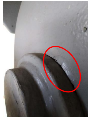
Obr. 9 Poškození protikorozi u koncového táhla (foto: Tomáš Dejmek)
