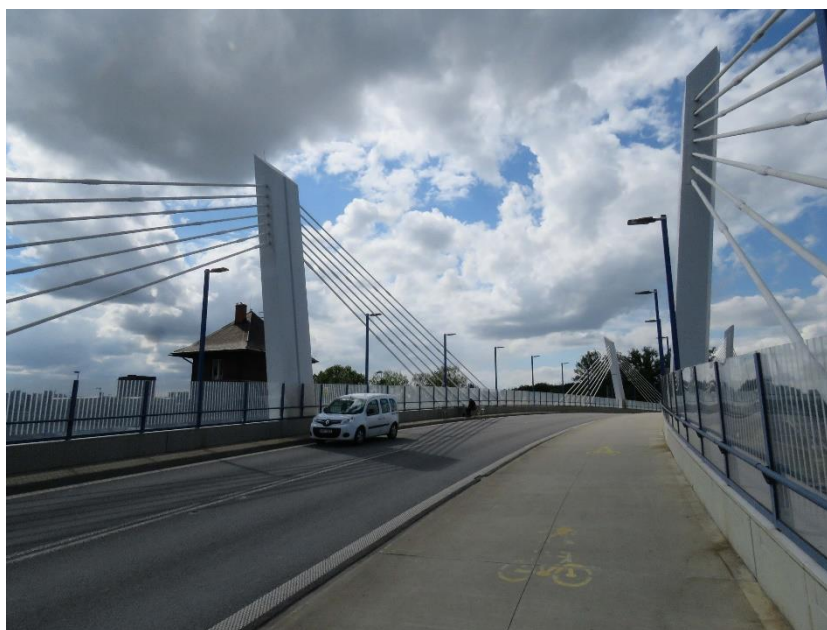
Obr. 7 Celkový pohled od opěry OP1 (foto: Michal Polák)
