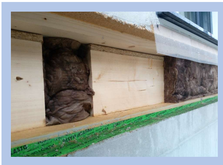
Obrázek 9. Zaizolování konstrukce v místě "věnce"
