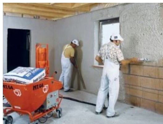
Obrázek 6: Strojní nanášení omítek [15]
