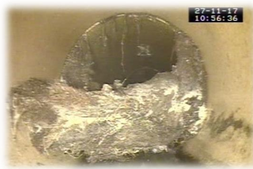
Obr. 9: Zablokovaný průchod potrubí kořenovým systémem (40) Obr. 10: Prorostlý kořen v kanalizaci (40)
