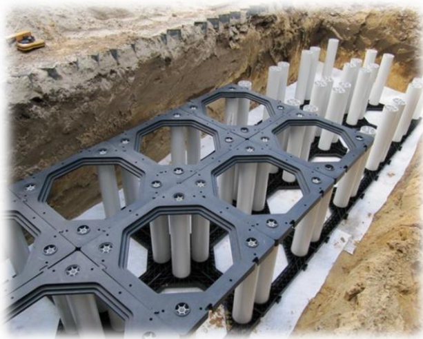
Obr. 16: Instalace prokořenitelných buněk (53)
