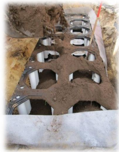
Obr. 17: Zасыпání zeminou (53)
