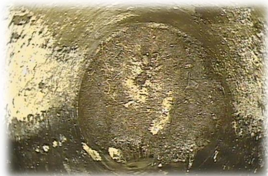
Obr. 9: Zablokovaný průchod potrubí kořenovým systémem (40) Obr. 10: Prorostlý kořen v kanalizaci (40)
