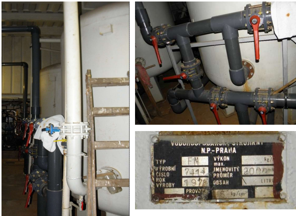
Obrázek 22. stávající filtry + štítek
