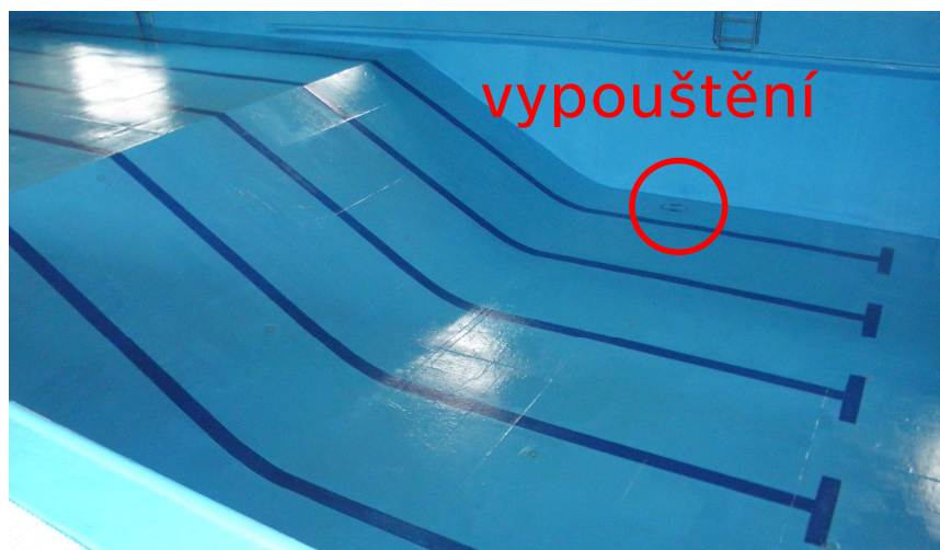
Obrázek 28. Pohled do hlubší části bazénu s vypouštěním
