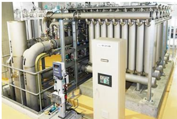
Obr. 29: Membránová filtrace s keramickými membránami [35]
