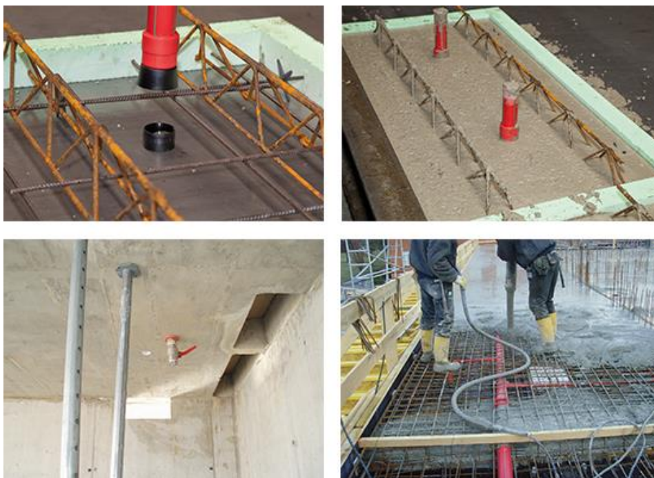
obr. 5: Instalace systémů aquatherm red pipe do betonu [12]
