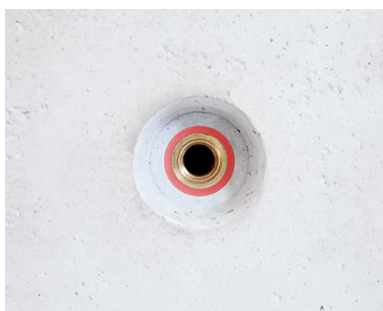
obr. 6: Výstup pro sprinklerovou hlavici z betonu [12]
