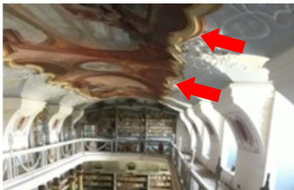
Obrázek 40: umístění hlásičů s ohledem na rozsáhlou fresku
