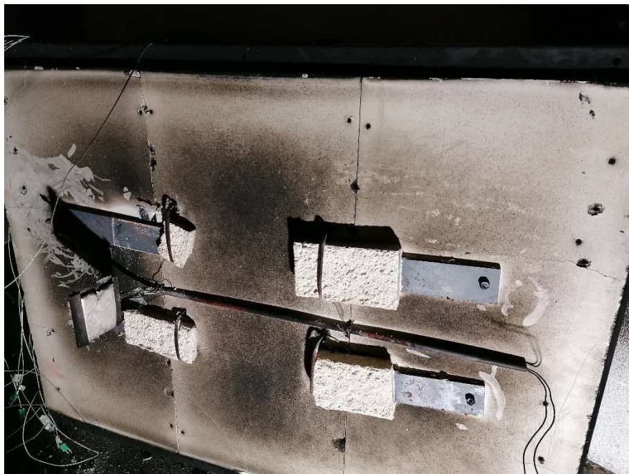
Obr. 59 Odpadnutí požární ochrany po ukončení zkoušky
