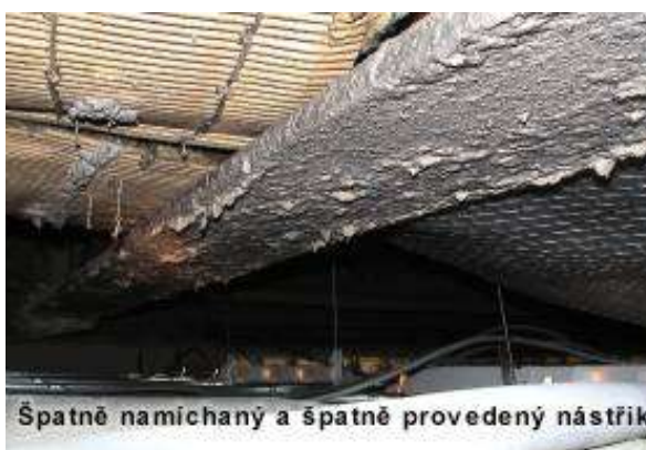
obr. 8 Špatně namíchaný nástřik [10]
