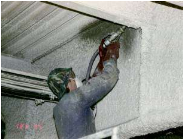
obr. 9 Ukázka aplikace nástřiku stříkací pistolí [11]
