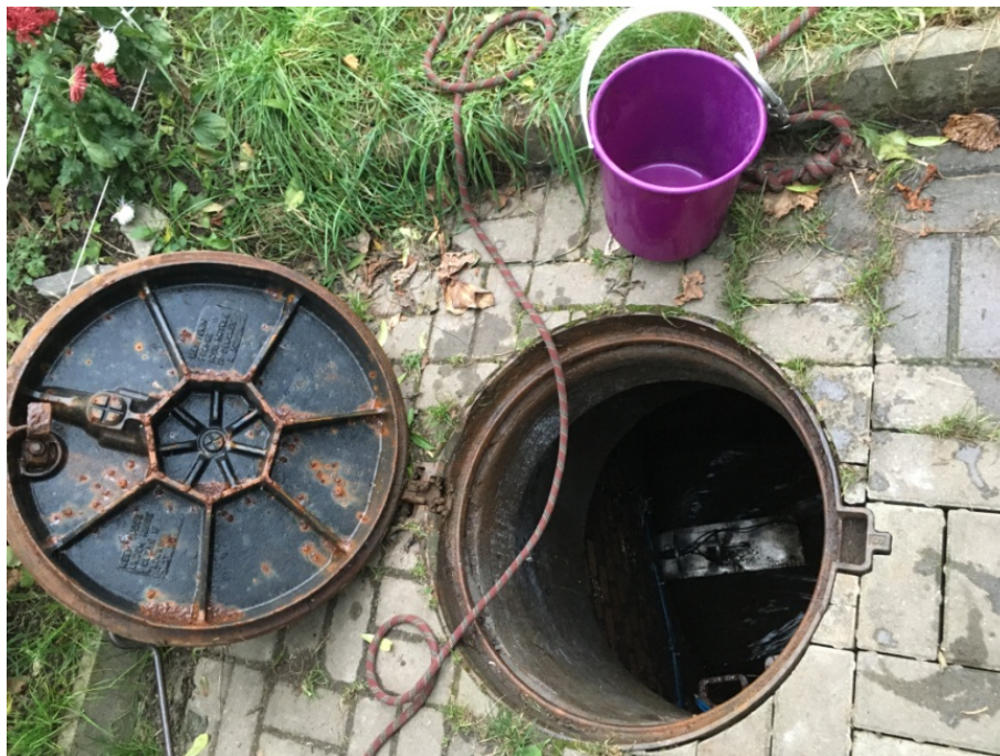
Obrázek 4.5- Pohled kontrolní šachtou na sondu profil D1-PAPÍRENSKÁ-Q
