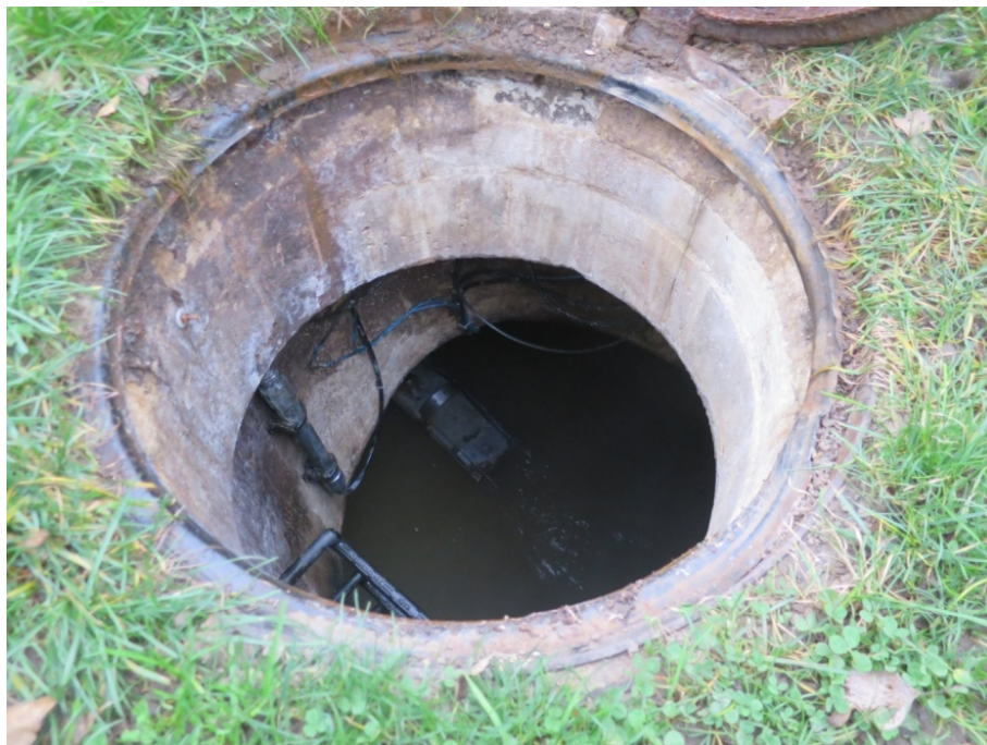
Obrázek 4.6- Pohled kontrolní šachtou na sondu profil E2-ZOO-Q
