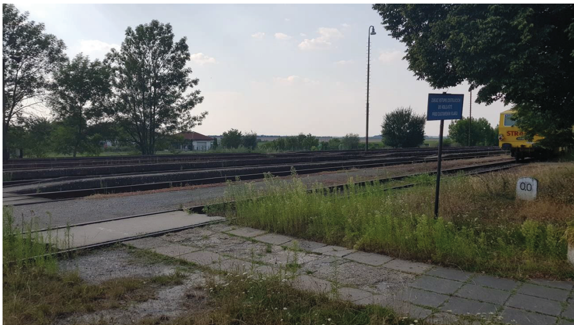
Obr. 1: Žst. Veleliby, přístup k nástupištím, km 0,000
