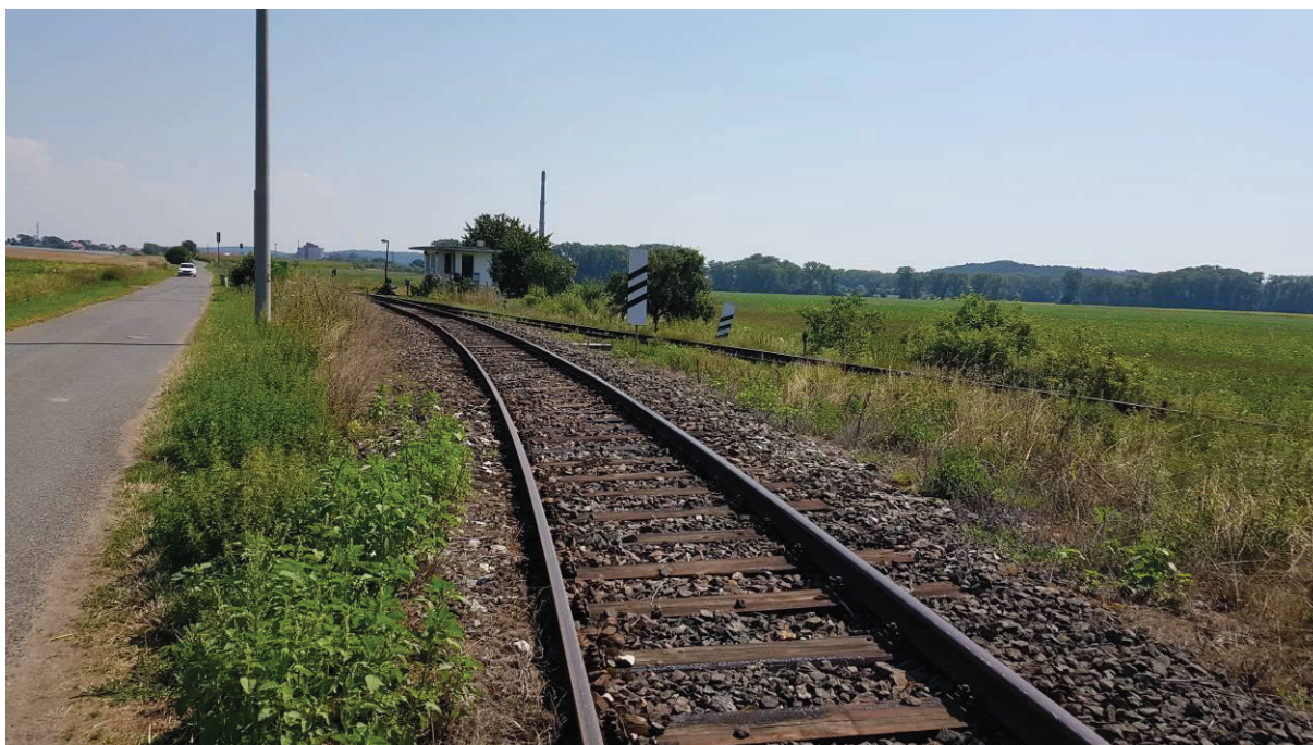
Obr. 27: Odbočka Kamensko, pohled směrem na Kopidlno 8. 8. 2020
