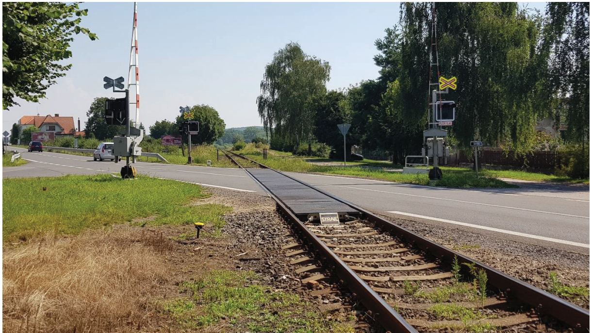
Obr. 32: Přejezd P4622 přes silnici I. třídy v Kopidlně 8. 8. 2020
