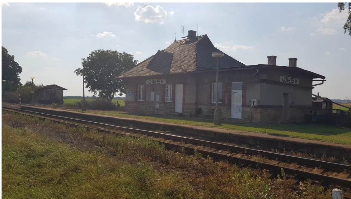
Obr. 3: Zastávka Jíkev, budova zastávky s nástupištěm
