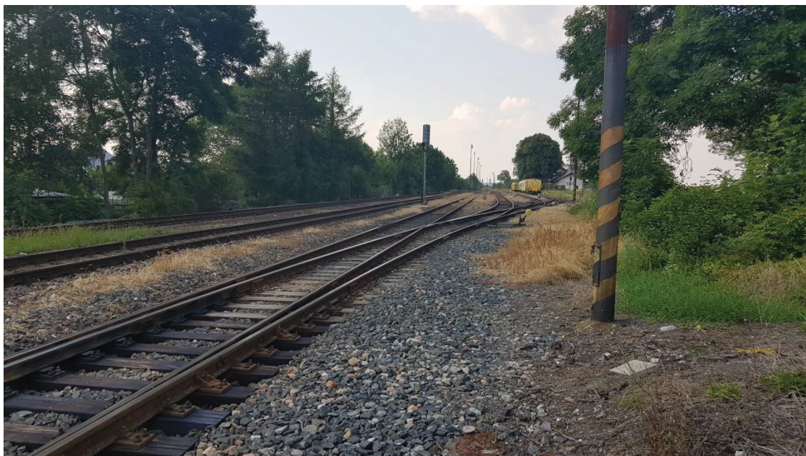
Obr. 2: Žst. Veleliby, pohled od přejezdu P2787 k výpravní budově
