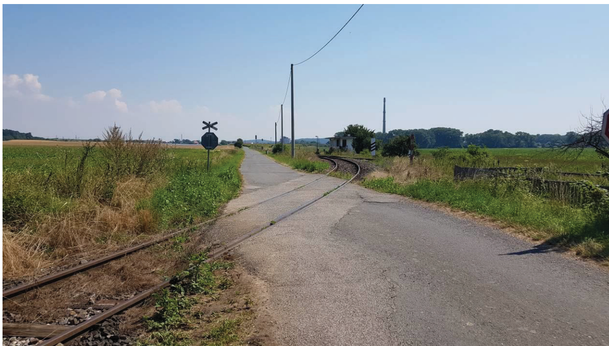
Obr. 26: Přejezd P9263 na trati Dolní Bousov – Kopidlno a v pozadí odb. Kamensko 8. 8. 2020
