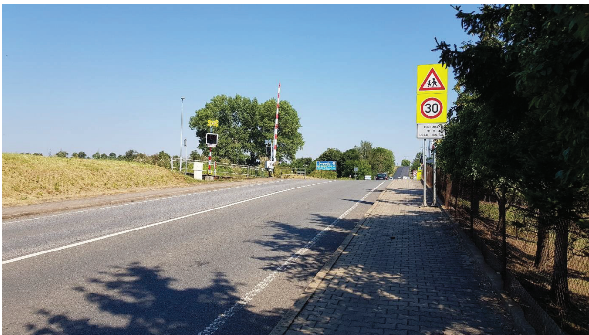
Obr. 38: Přejezd P4629 přes silnici I. třídy v Jičíněvsi
