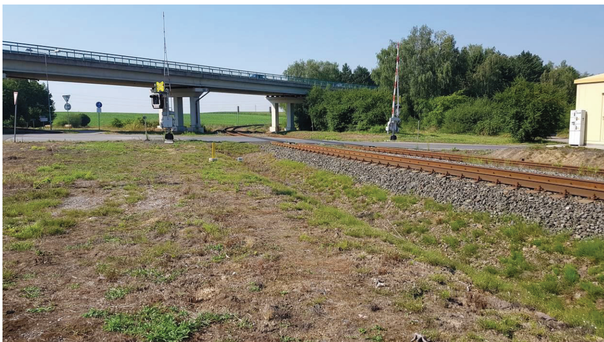
Obr. 47: Přejezd P3134 v Jičíně, pravá kolej směrem na Nymburk
