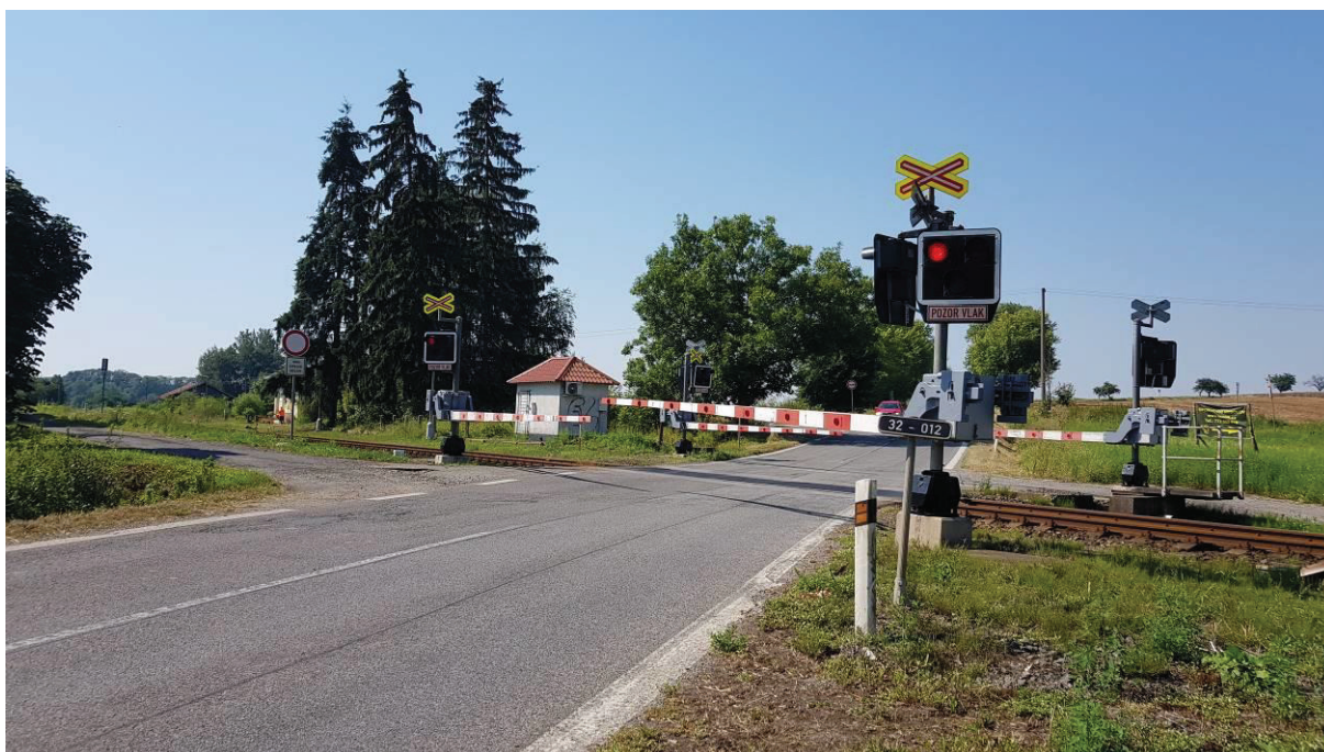
Obr. 37: Přejezd P4627 přes silnici I. třídy v Bartoušově
