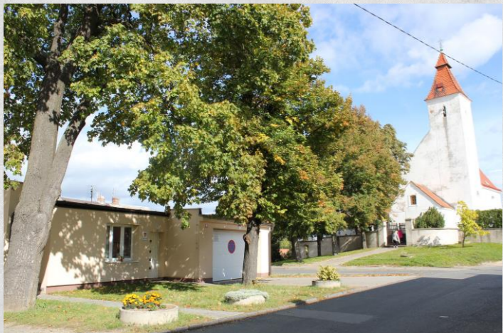
7. Objekt technických služeb
