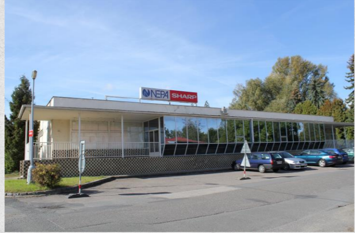
14. NEPA, bývalá samoobsluha
