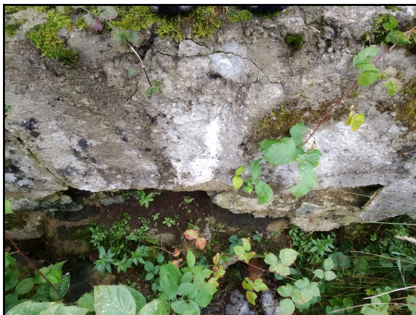
Foto 5: Pohled na propustek na přítoku – DN 300
