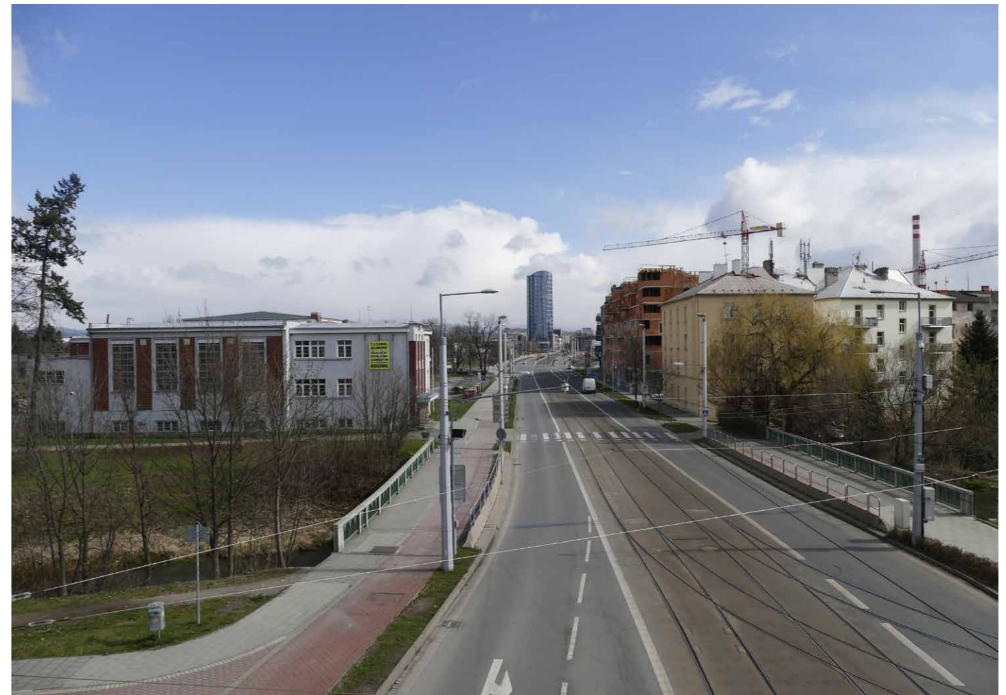
OBR. 13 POHLED Z PĚŠÍHO MOSTU NA ULICI KOSMONAUTŮ, foto Michal Vitek
