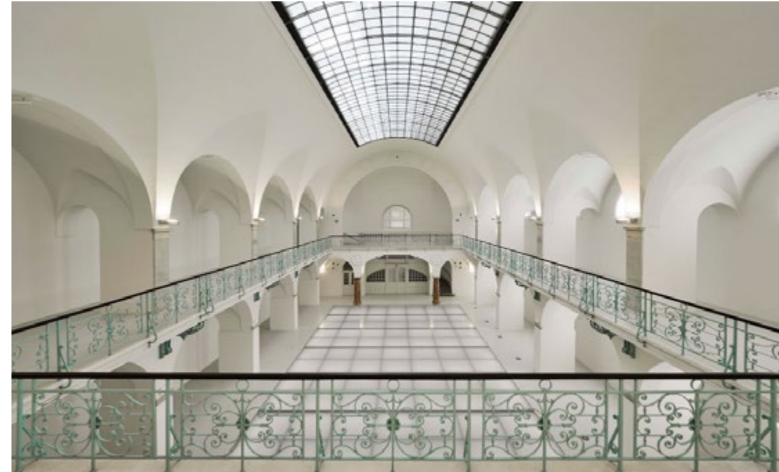
Obr. 2.84 Bývalá bazénová hala
