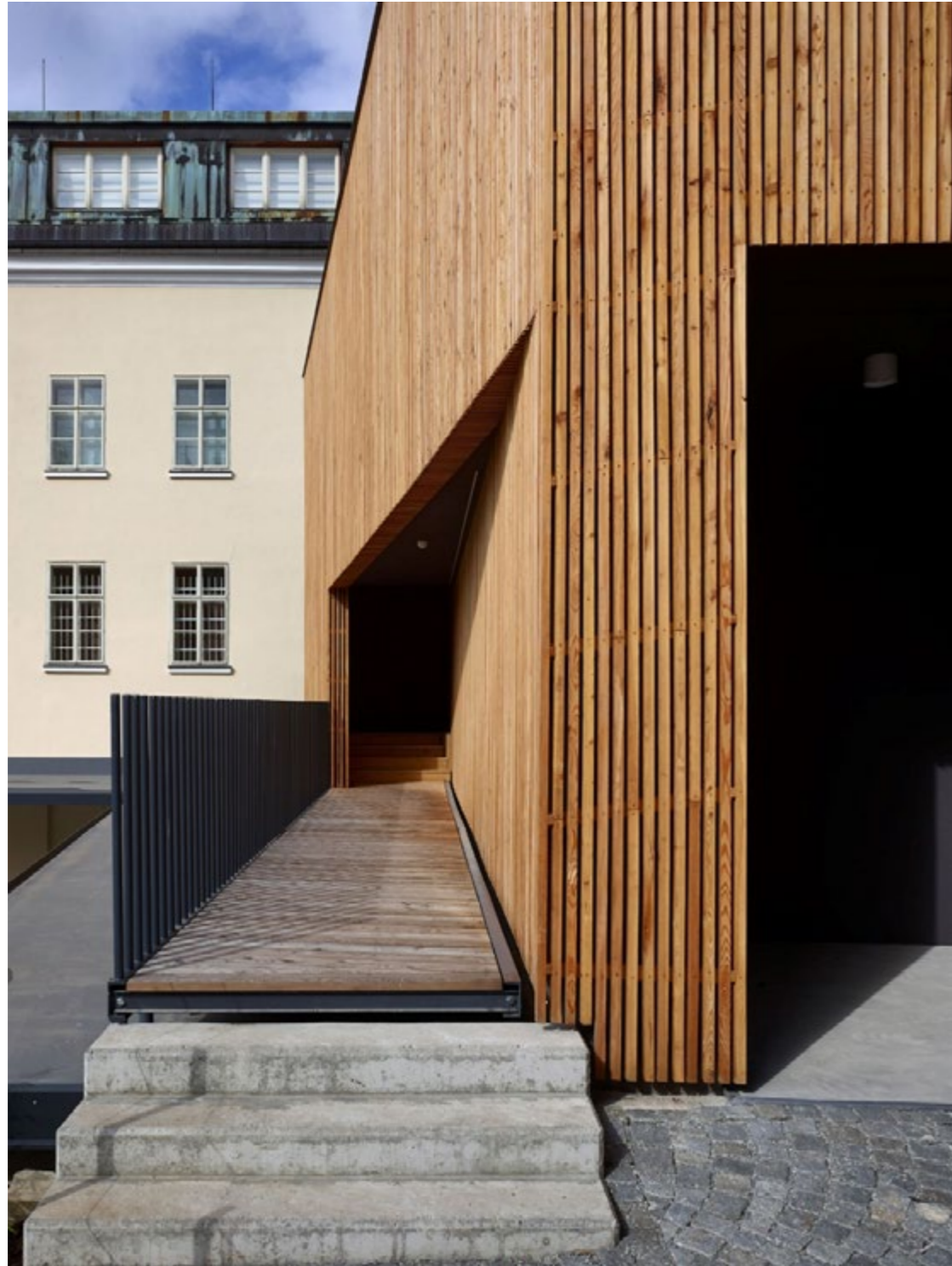
Obr. 2.77 Efektní vstup k depozitáři, spíše formální prvek
