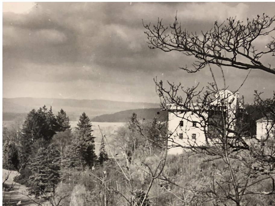
Oprava střeby hradu v roce 1958 [Dobříš archiv]
