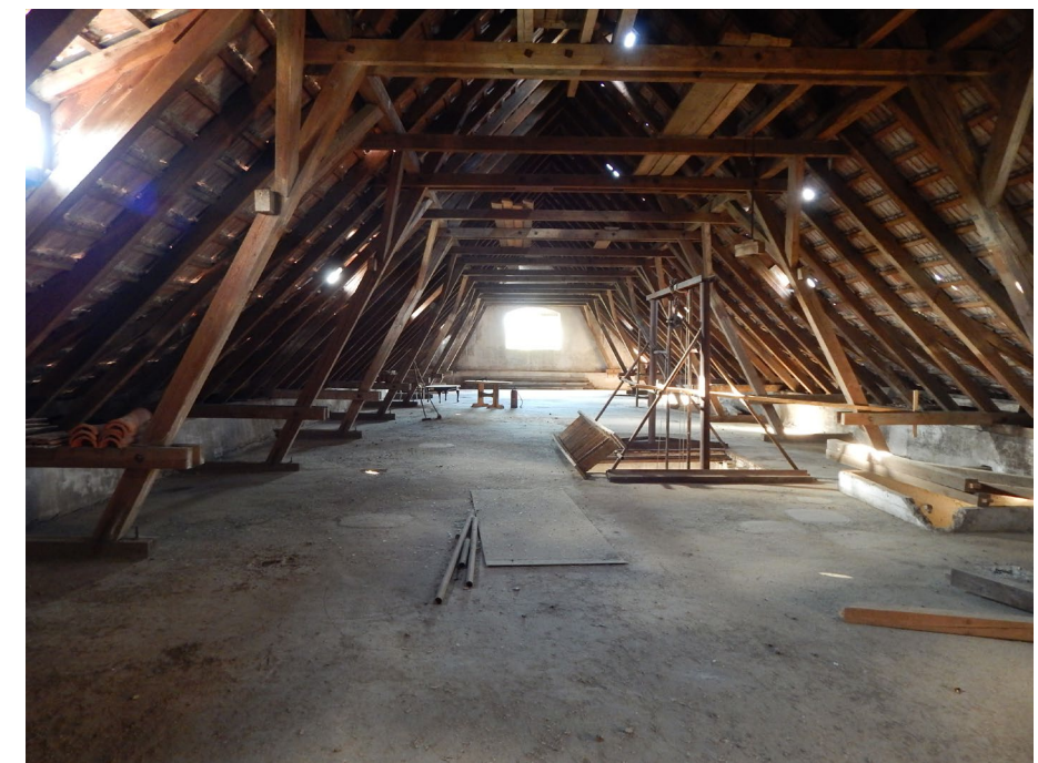
Konstrukce krovu Vargače. [Vlastní foto]
