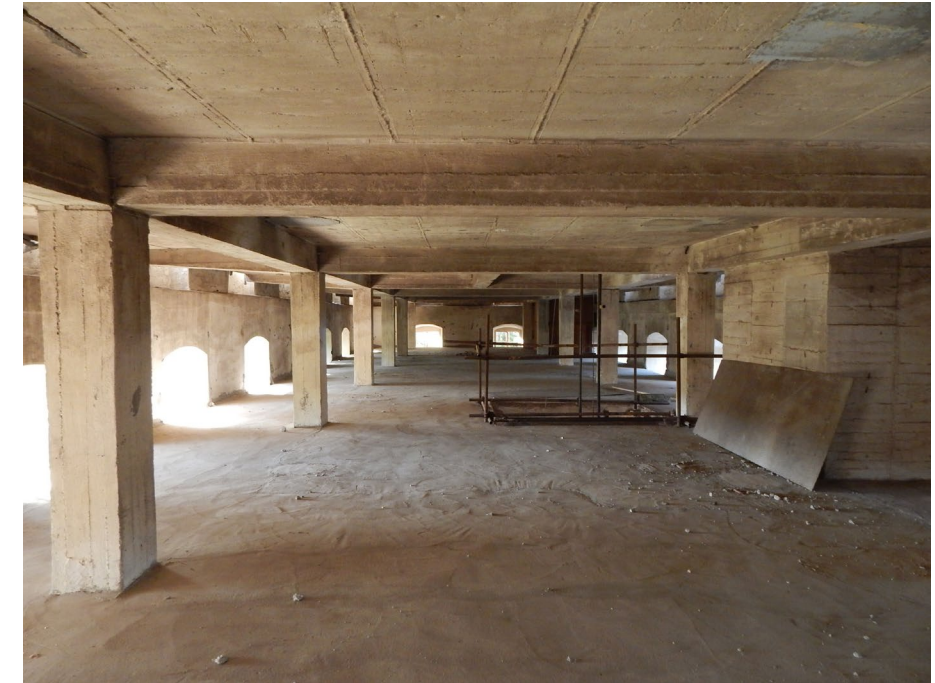
Železobetonový skelet uvnitř hradu. [Vlastní foto]
