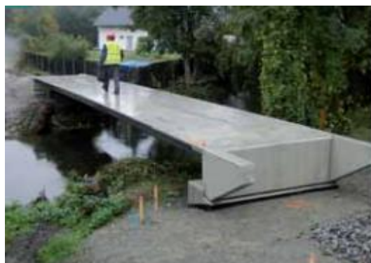
Obr. 7 Lávka pro pěší v obci Čeperka [29]
