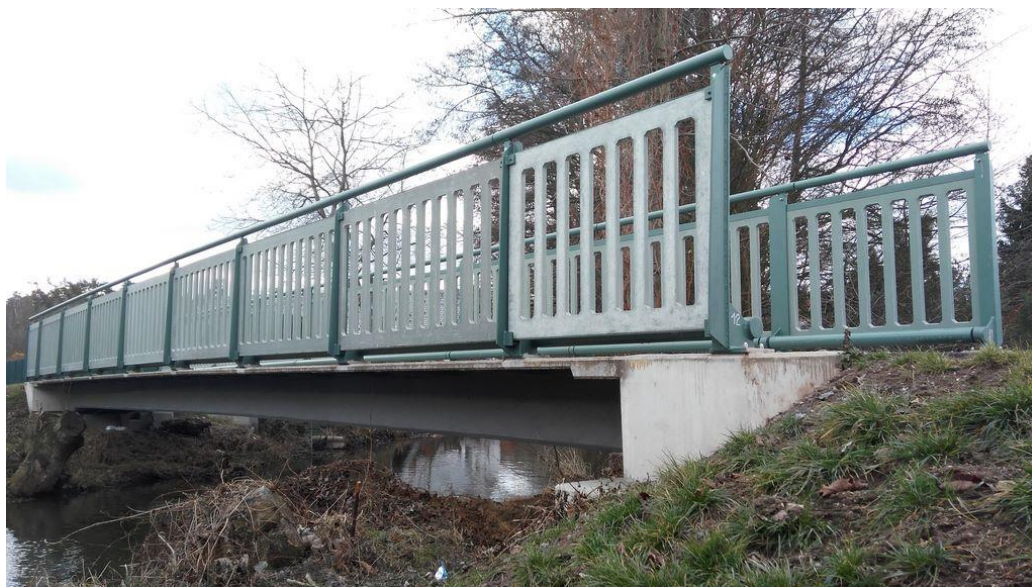
Obr. 6 Lávka pro pěší v obci Čeperka [28]
