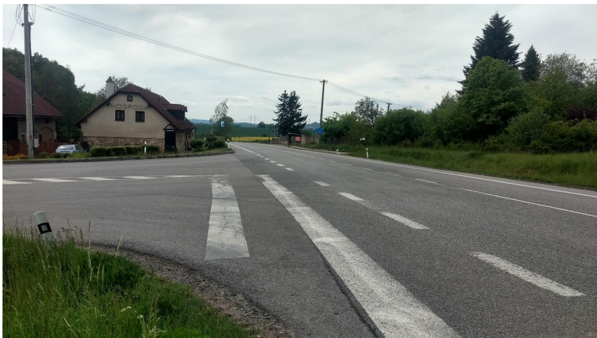
Obr.č.47 – Pohled směrem od Náchoda na křižovatku u Dřevěnic [24]
