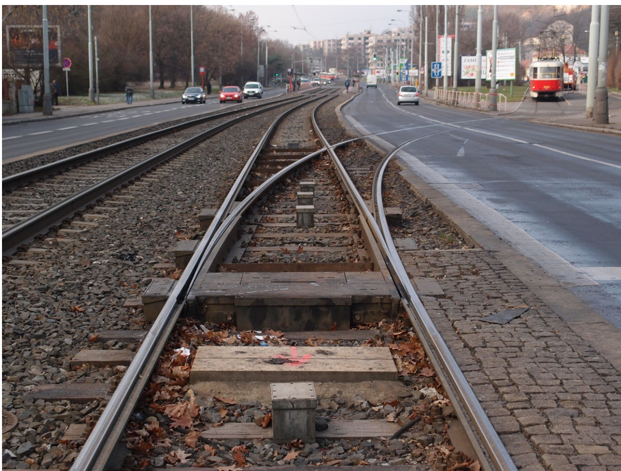
Obr. 6. Výhybka číslo 567 – vjezd do obratiště Kotlářka. Vpravo od koleje je vidět zablážděná plocha pro snazší přístup k výhybce při ručním přestavování (12/2016, archiv J. Hradila).
