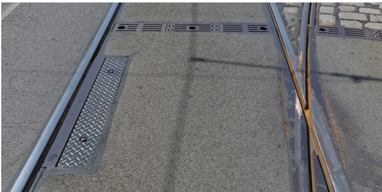
Obr. 15. Skříňka s možností nastavení šířky žlábků v protikolejnici u rychlostní výhybky R 02, díky níž je možné vést dvojkolí při průjezdu v ideální stopě (7/2020, archiv J. Hradila).
