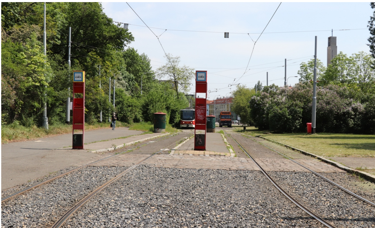
Obr. 13. Prostor nástupních zastávek v obratišti Kotlářka. Na konci zastávek jsou vidět zásobníky na písek, v popředí pak místo pro přecházení (5/2020, archiv J. Hradila).
