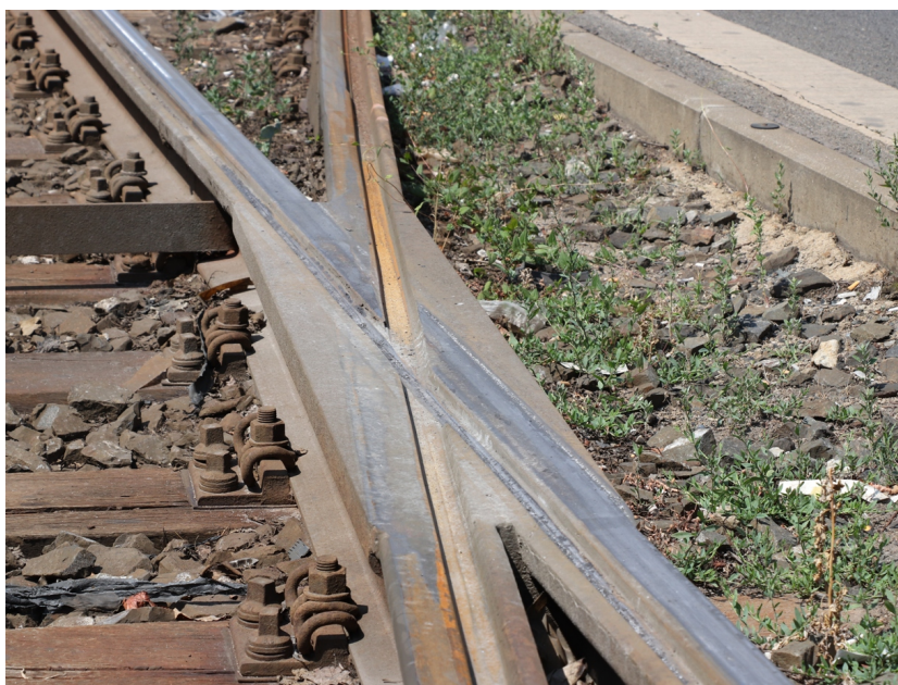
Obr. 8. Snímek ze současnosti dokumentuje nahrazení původní „hluboké“ srdcovky „mělkou“. Jak je však vidět z ojetí temene kolejnice v přímé, hloubka žlábků již nedosahuje potřebné hodnoty a srdcovka je pojížděna zároveň po okolku i nákolku (7/2019, archiv J. Hradila).
