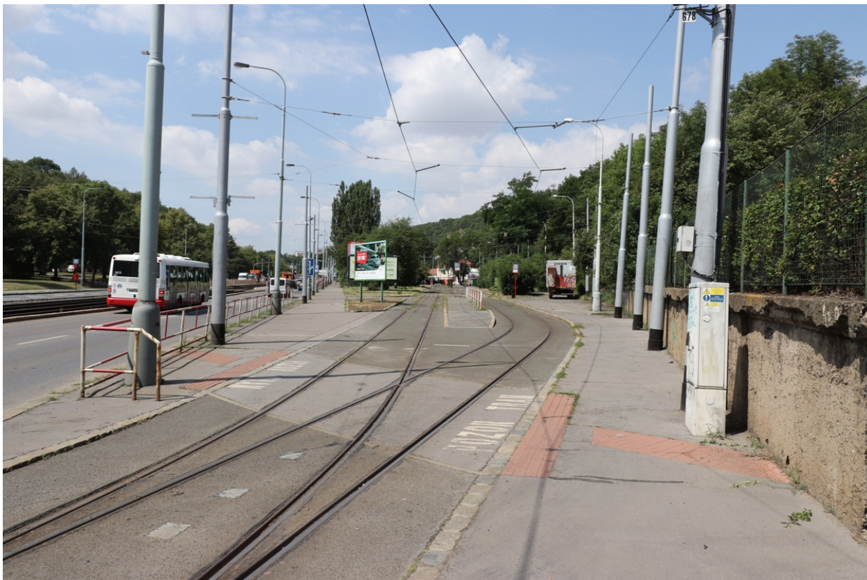
Obr. 14. Pohled na místo pro přecházení přes vjezd do obratiště Kotlářka. Vlevo je patrné navedení nevidomého k zábradlí podél komunikace, které v pozadí končí. Vpravo jsou zase patrné stožáry TV podél vodící linie (7/2019, archiv J. Hradila).
