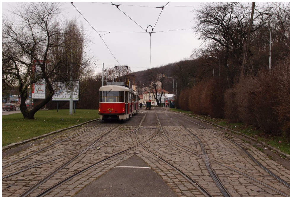
Obr. 11. Prostor pro manipulaci v obratišti Kotlářka. Ze snímku je patrná malá osová vzdálenost kolejí a jejich délka pouze na odstavení jedné soupravy (11/2016, archiv J. Hradila).
