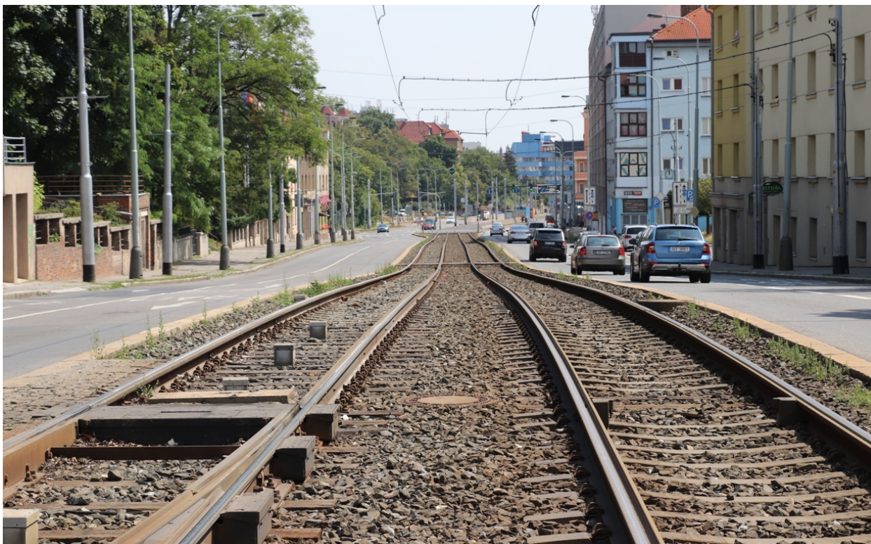
Obr. 5. Pohled na trať od vjezdu do obratiště směrem ke Kavalírce (7/2019, archiv J. Hradila).
