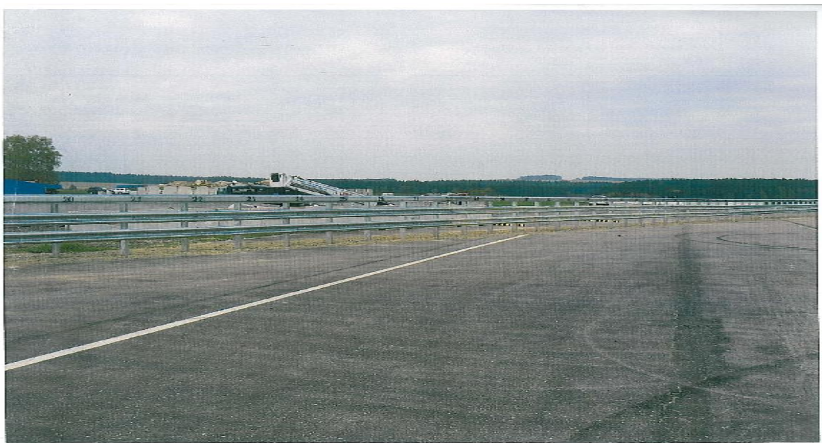
Obr. 10 Vzorek ocelového svodidla před zkouškou
