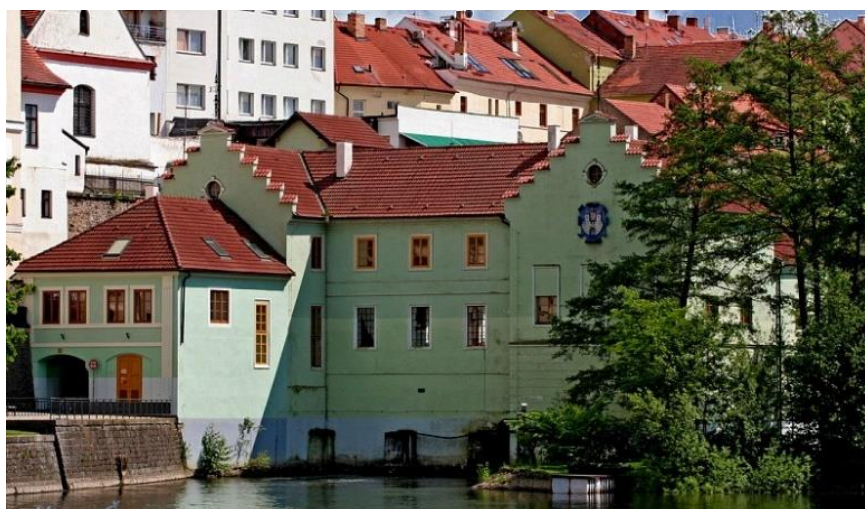
Obrázek 33 Bývalý mlýn v Písku přestavěný na elektrárnu 159
