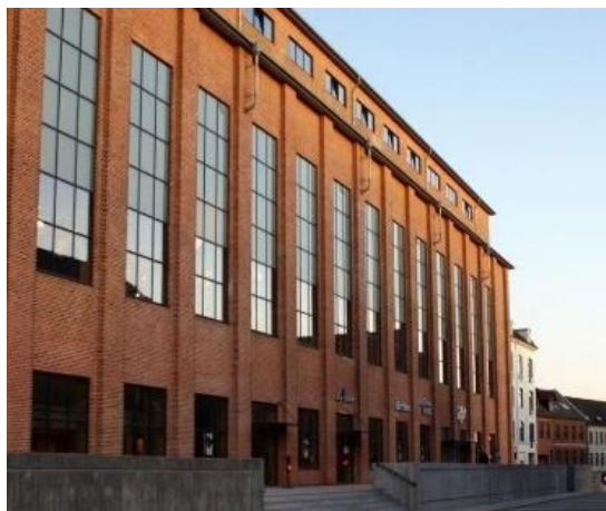
Obrázek 3 Část elektrárny z roku 1942 (foto autorky)
