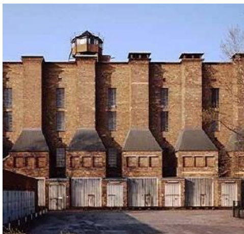
Obrázek 145 Před adaptací rozvodny 458
