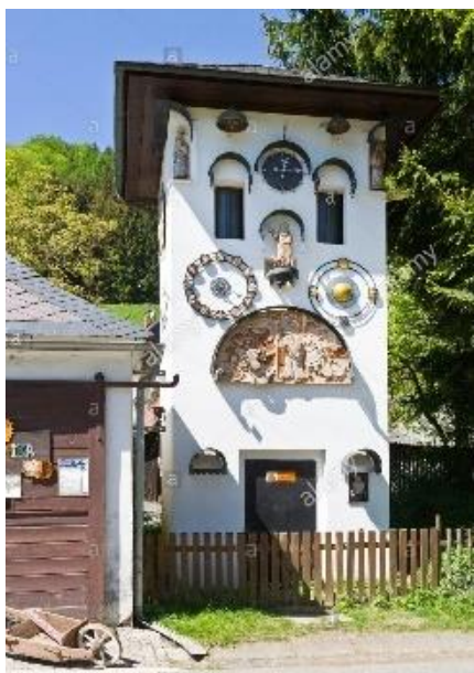
Obrázek 155 Z již nepoužívané trafostanice vznikl orloj, oblíbené místo mnoha výletů 477
