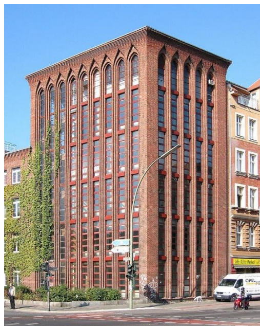
Obrázek 152 Po adaptaci rozvodny 471
