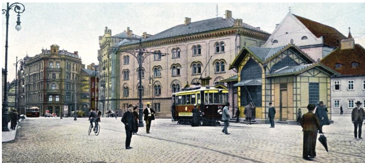
Obrázek 86 Objekt přepínací stanice na dnešním náměstí Republiky, který sloužil současně jako zapínací stanice veřejného osvětlení a čekárna elektrické dráhy kolem roku 1903 352
