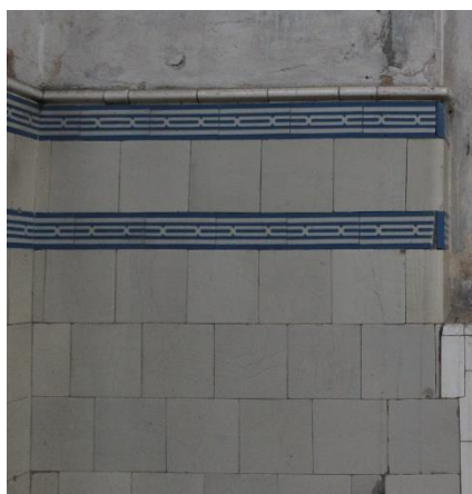
Obrázek 58 Detail keramického obkladu ve strojovně 246
