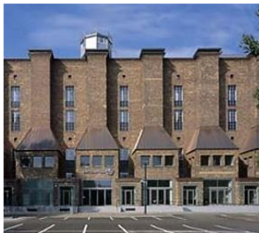
Obrázek 146 Po adaptaci rozvodny 459
