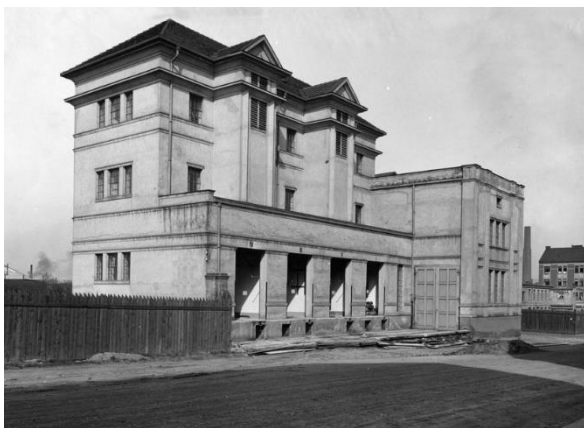
Obrázek 74. Teslova rozvodna ve výstavbě-1924 305
