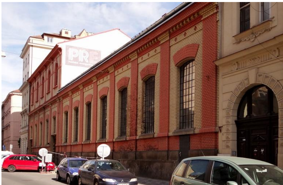
Obrázek 46 Pohled na fasádu smíchovské elektrárny, stav v roce 2014 209
