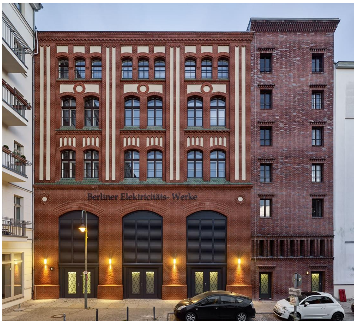
Obrázek 148 Rozvodna Koppenplatz po adaptaci 462
