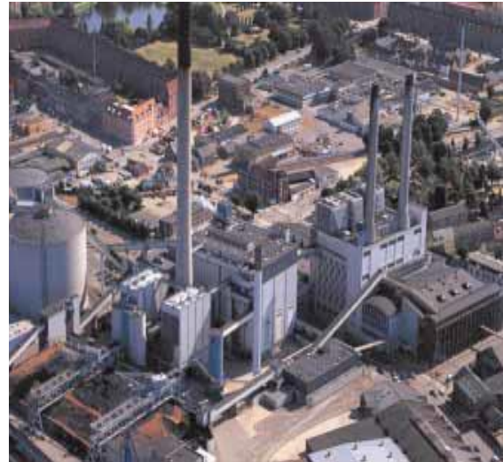
Obrázek 5 Celkový pohled na elektrárnu Nordkraft z 80. let i s mazutovým hospodářstvím 29
