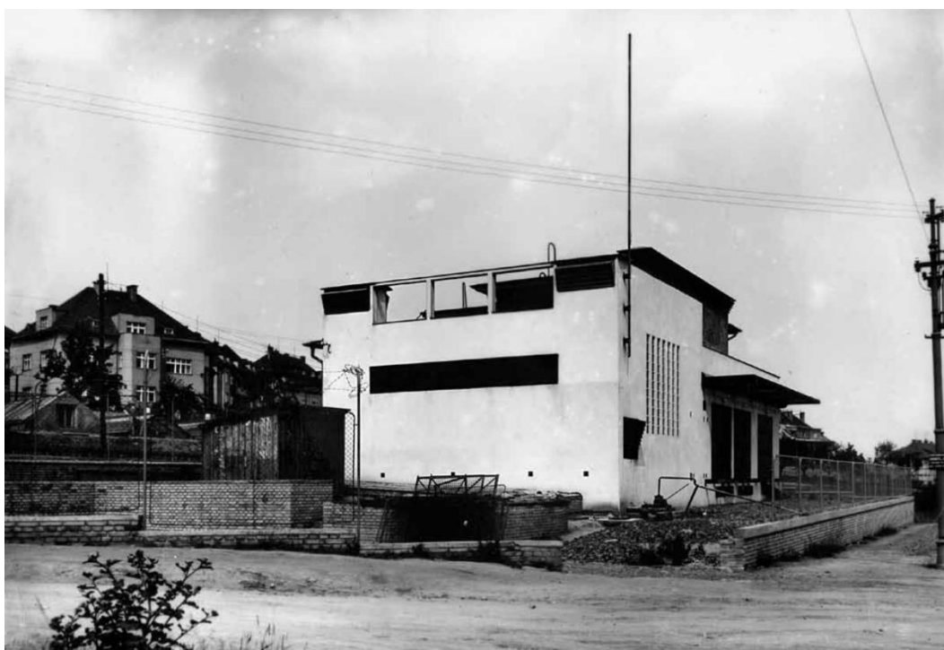
Obrázek 73 Transformační a měničárna stanice Vokovice (měničárna Bořislavka) v roce 1932, zbořena 300
