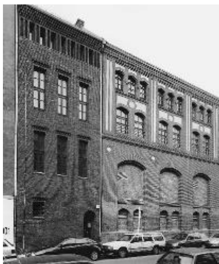
Obrázek 149 Původní stav rozvodny 466
