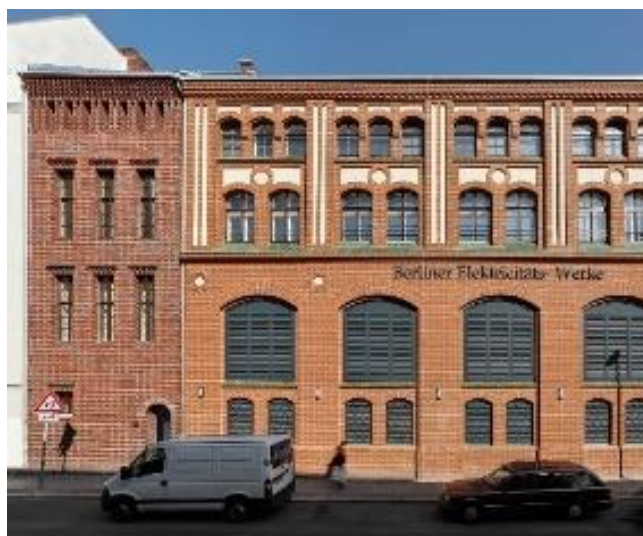
Obrázek 150 Po adaptaci rozvodny 467
