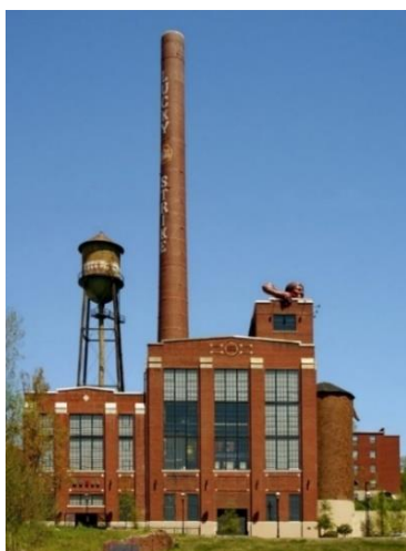
Obrázek 117 Budova původní elektrárny po adaptaci 419
