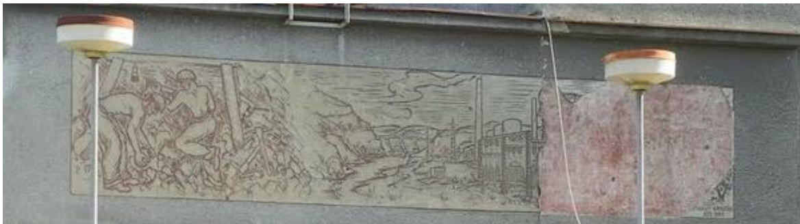
Obrázek 24 Vstupní bránu do Oslavanské elektrárny zdobí freska dýmající elektrárny a dělníka rubajícího zdejší uhlí 115
