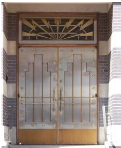
Obrázek 22 To je místo, kde by zákazníci vstupovali do elektrárny Ottawa Street Power Station, aby zaplatili účty za elektřinu 113
