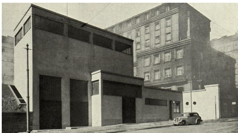
Obrázek 89 Měničrna Bělohorská, v původní podobě v době vzniku 359
