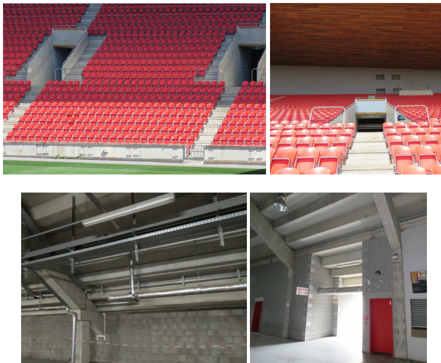
Obrázek 21: Pohledy na sledovanou část stadionu v Praze v Edenu a na nosnou konstrukci zkoumané tribuny
