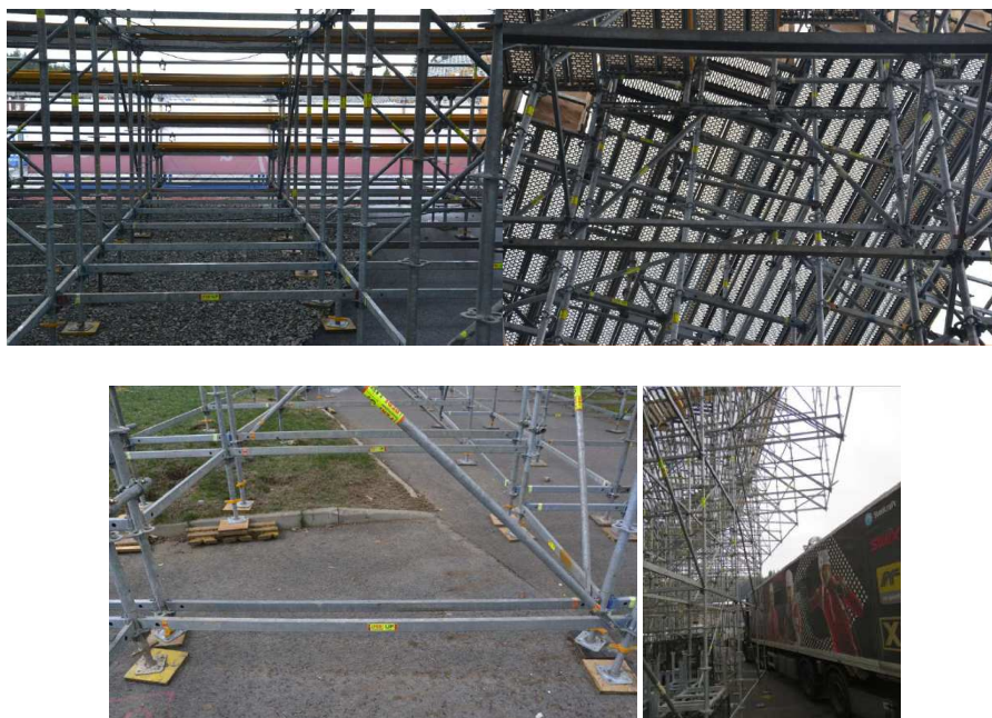
Obrázek 29: Pohled na nosné prvky sledované ocelové montované tribuny
