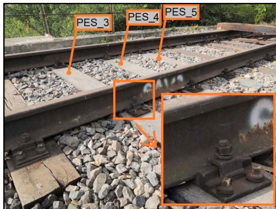
Obr. 71: Pražce typu PES z recyklovaného polymeru připravené pro stanovení požární bezpečnosti
