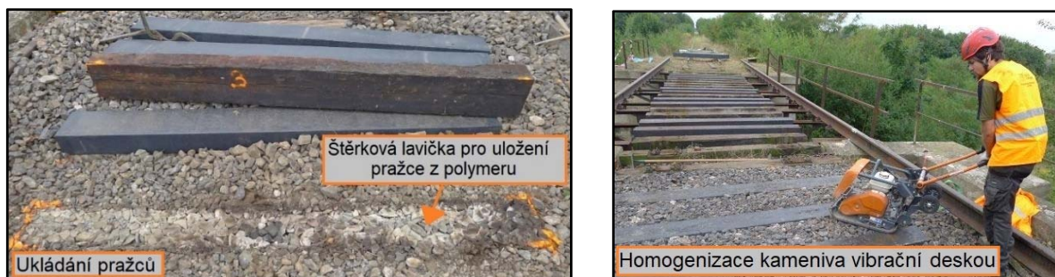
Obr. 47: Příprava pražců z polymeru pro stanovení jejich příčného odporu in situ [12]
