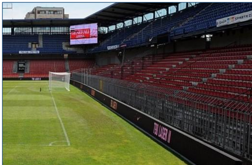
Obrázek 20: Bezpečnostní oplocení sektoru fanoušků v Generali aréně [54]
