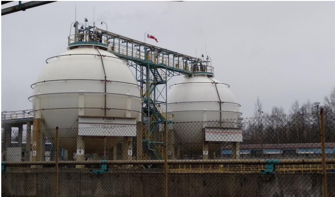
Obrázek 8 - kulové zásobníky propylenu společnosti Synthomer a.s. [zdroj vlastní]
