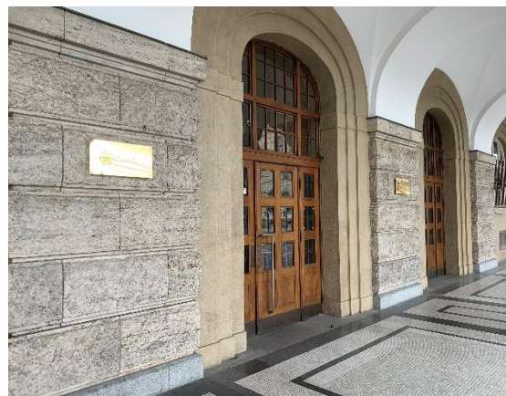
Obr. 17 - Hlavní vchod FF UK Zdroj: vlastní fotografie
