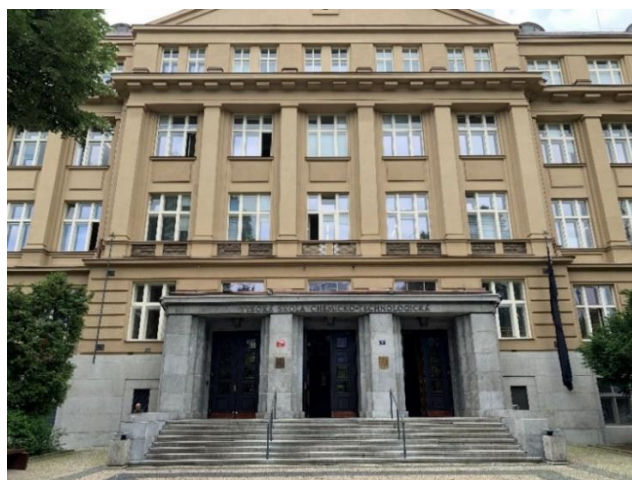
Obr. 8 - Hlavní vchod do objektu „B“ z ul. Technická Zdroj: vlastní fotografie
