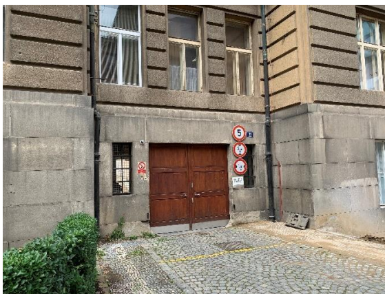
Obr. 5 - Vjezd č. 1 z ul. Studentská Zdroj: vlastní fotografie
